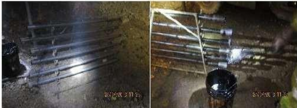
Figura 35. Rotación de las barras y engrasado de las roscas
