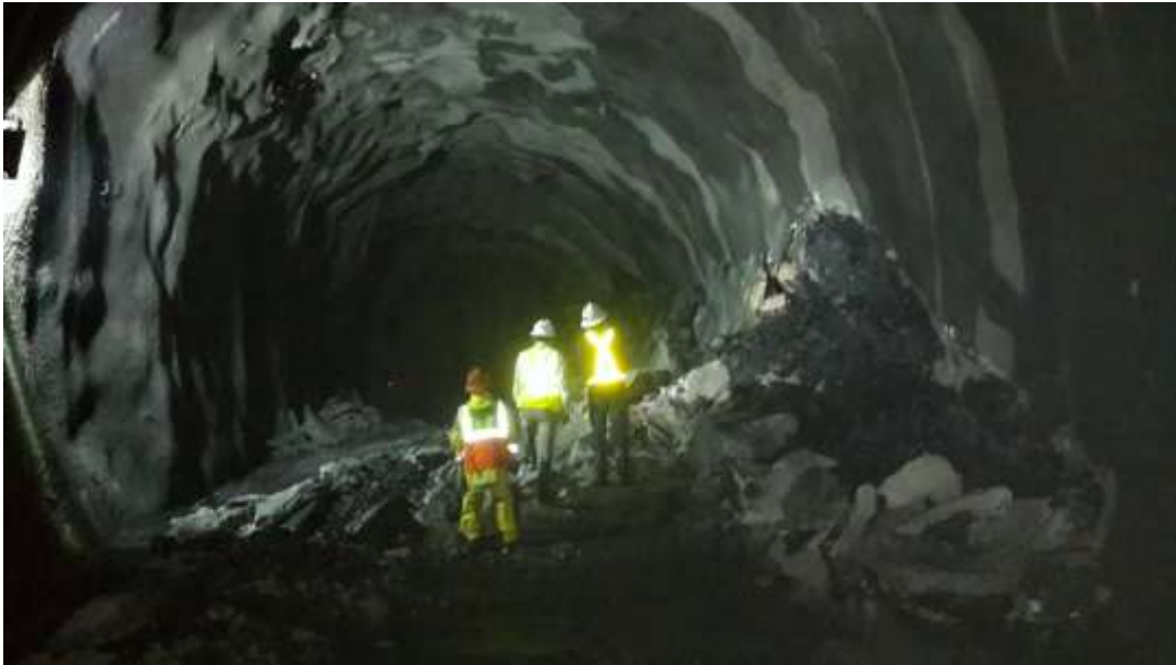
Foto 2 Deformacion del piso y presencia de agua en el Frente 04
