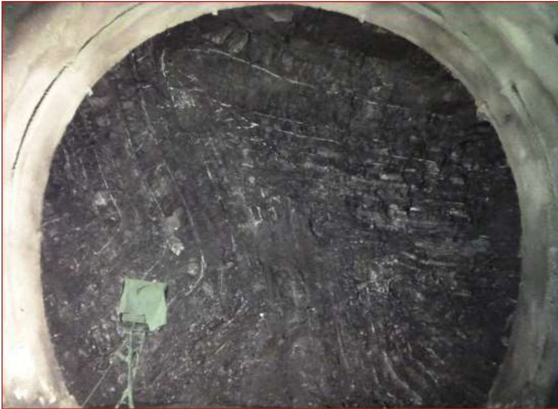
Foto 6 Macizo rocoso del Frente 04 Ventana 02 del Tunel de Aduccion.
