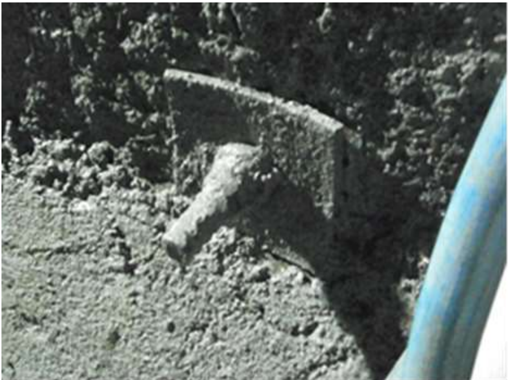
Foto 4 También se observó que las platinas de los pernos colocados entre las cimbras se deformaron en el tramos por los esfuerzos compresionales.
