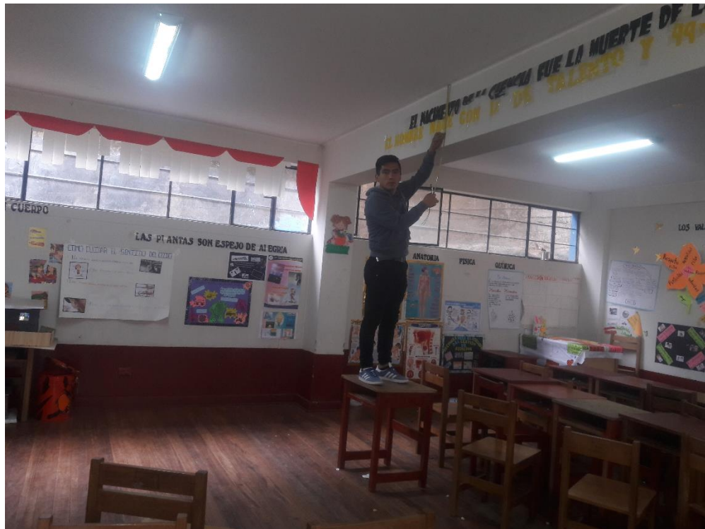
Imagen 3. Medición de secciones de vigas.
