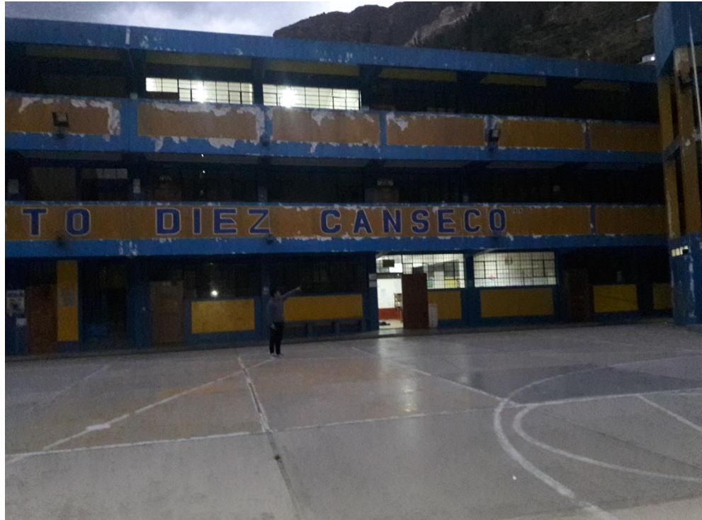
Imagen 1. Vista frontal de la estructura del pabellón B de la Institución Educativa Ernesto Diez Canseco.
