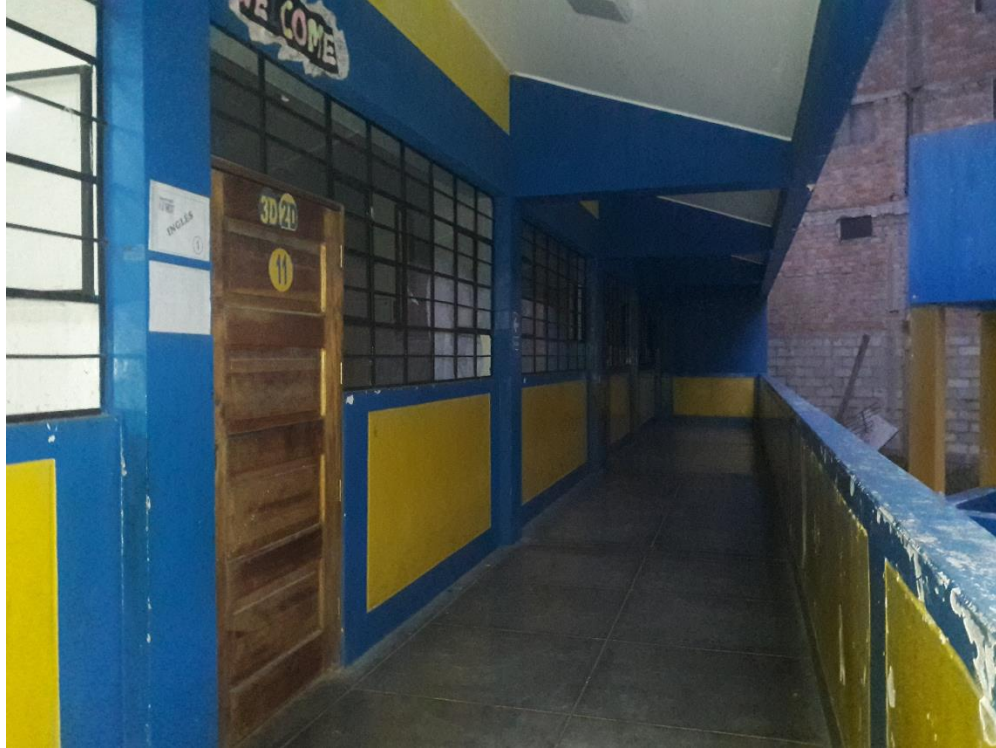
Imagen 7. Corredor típico del segundo y tercer nivel
