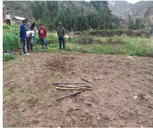
Fig 2 Limpieza de terreno
