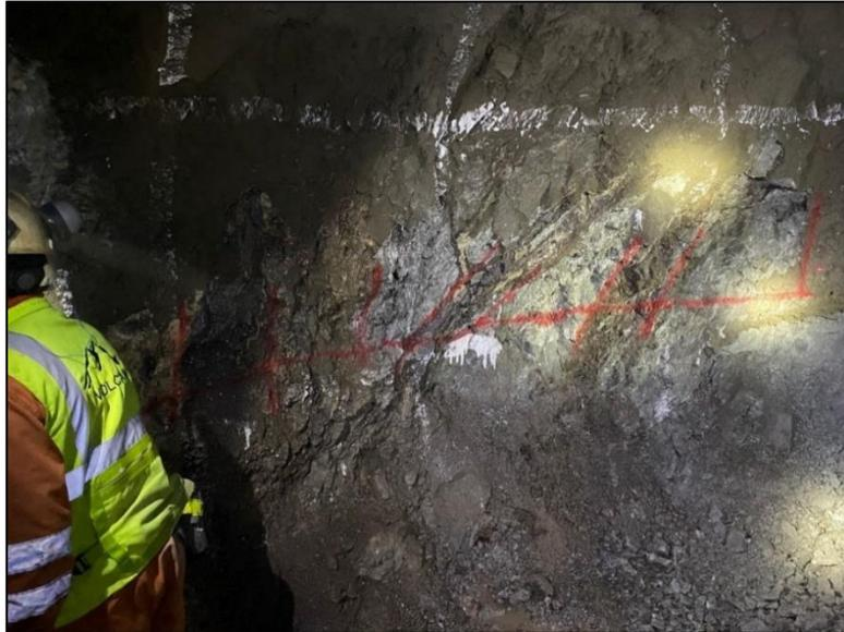
D. Se puede realizar el corte del canal de manera manual utilizando un puntero y una comba, o bien empleando una máquina cortadora equipada con disco diamantado.
