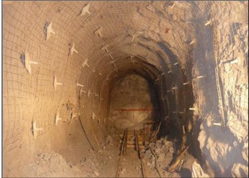
Fuente: Área de geomecánica U. M. Animón Chungar.
