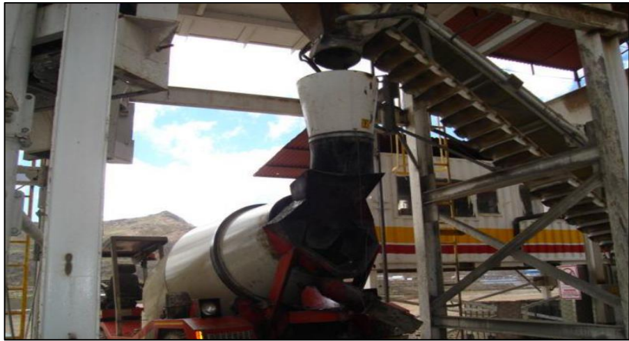
Gráfico 32 Abastecimiento de material para el shotcrete vía húmeda
