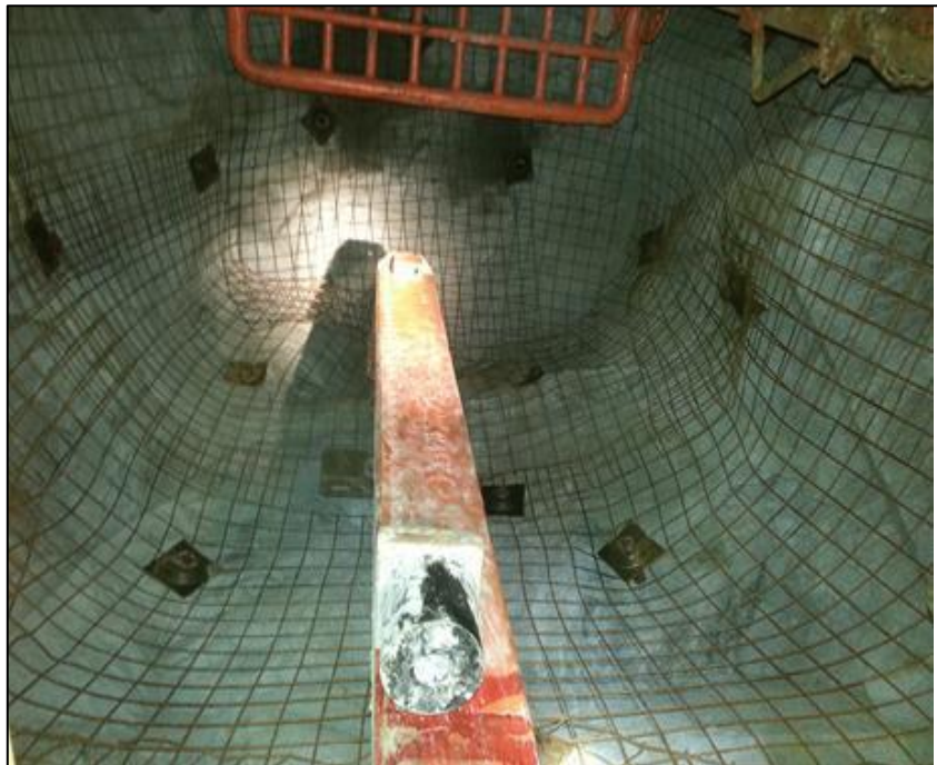
Fuente: Área de geomecánica U. M. Animón Chungar.
