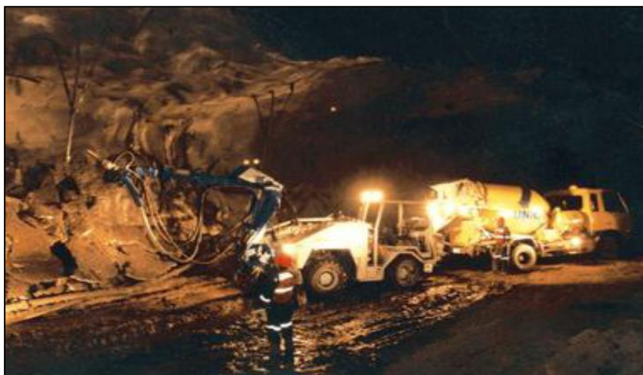
Gráfico 33 Proceso de lanzamiento del concreto robotizado vía húmeda
