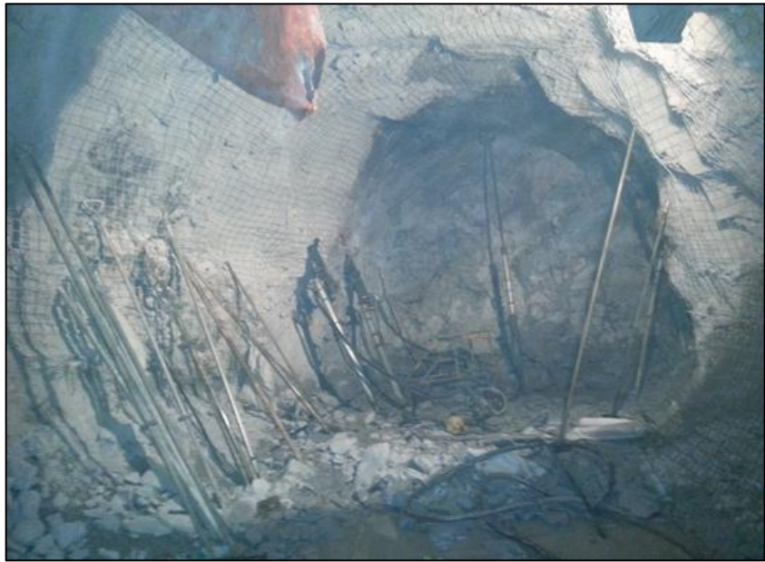
Gráfico 26 Sostenimiento en galerías
