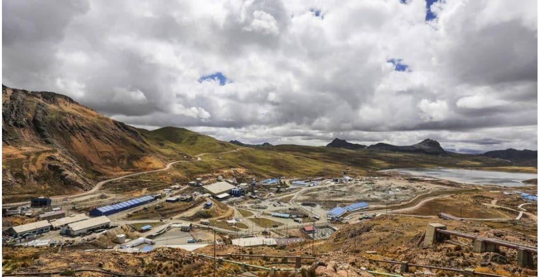
Foto 001. Vista Panorámica de la Mina Huarón
