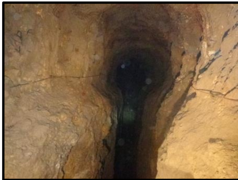
Ilustración 24. Tajo para Relleno Hidráulico
