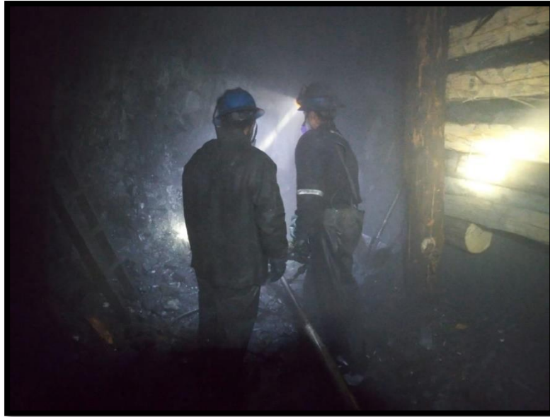
Perforación de frente en el SN-140.
