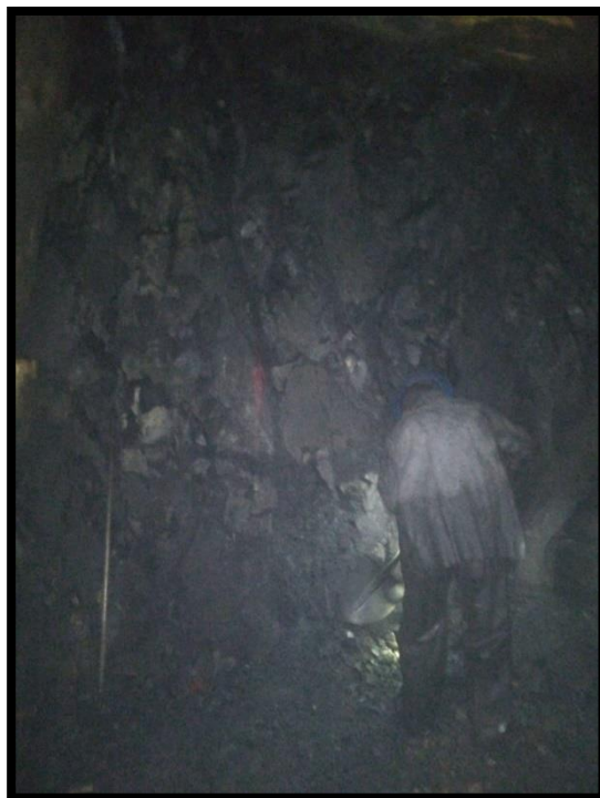
Frente Listo para Perforación.
