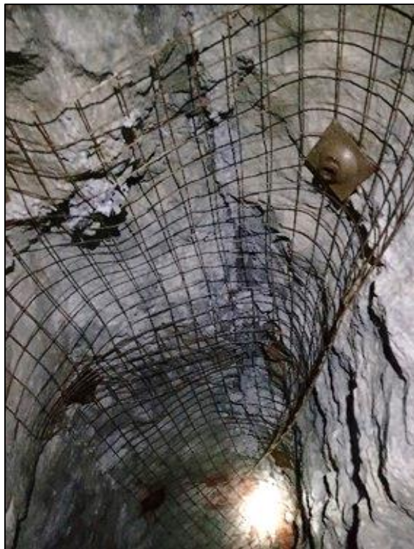
Foto 002: Sostenimiento de Labores con Malla y Split Set
