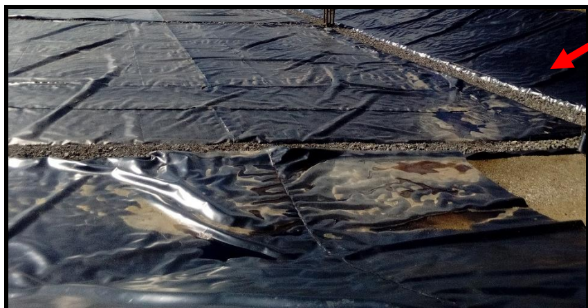
Imagen N° 01- Sistema recolección de Lixiviados
