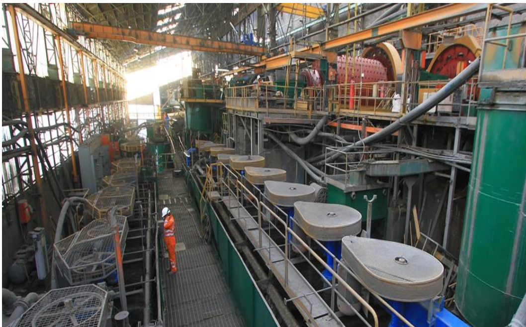
Foto 4: Molienda y circuito de Flotación de Bulk
