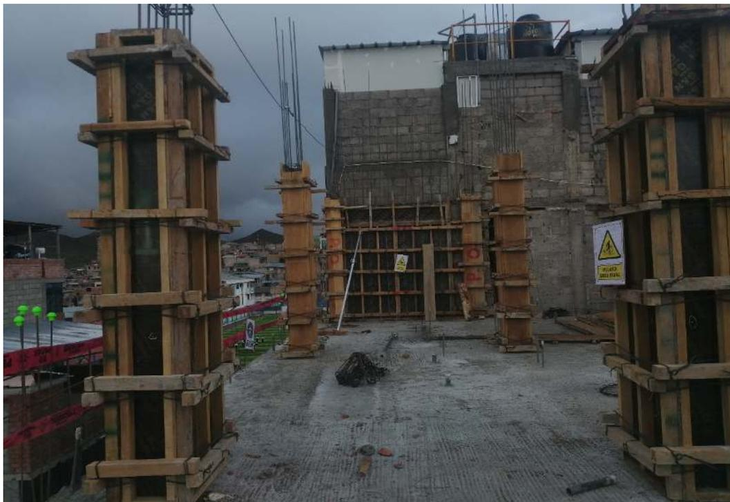
*Fotografía: Vaciado de concreto en elementos verticales en el piso 5 - Todos los sectores*
