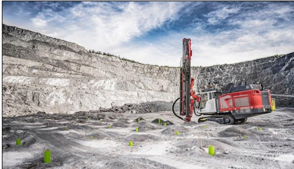
Figura 05. Equipo de perforación DP1500i.
