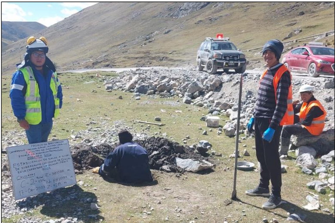
Fotografía 2. Calicata N° 02 - E: 364588, N: 8821474, Z: 4219.
