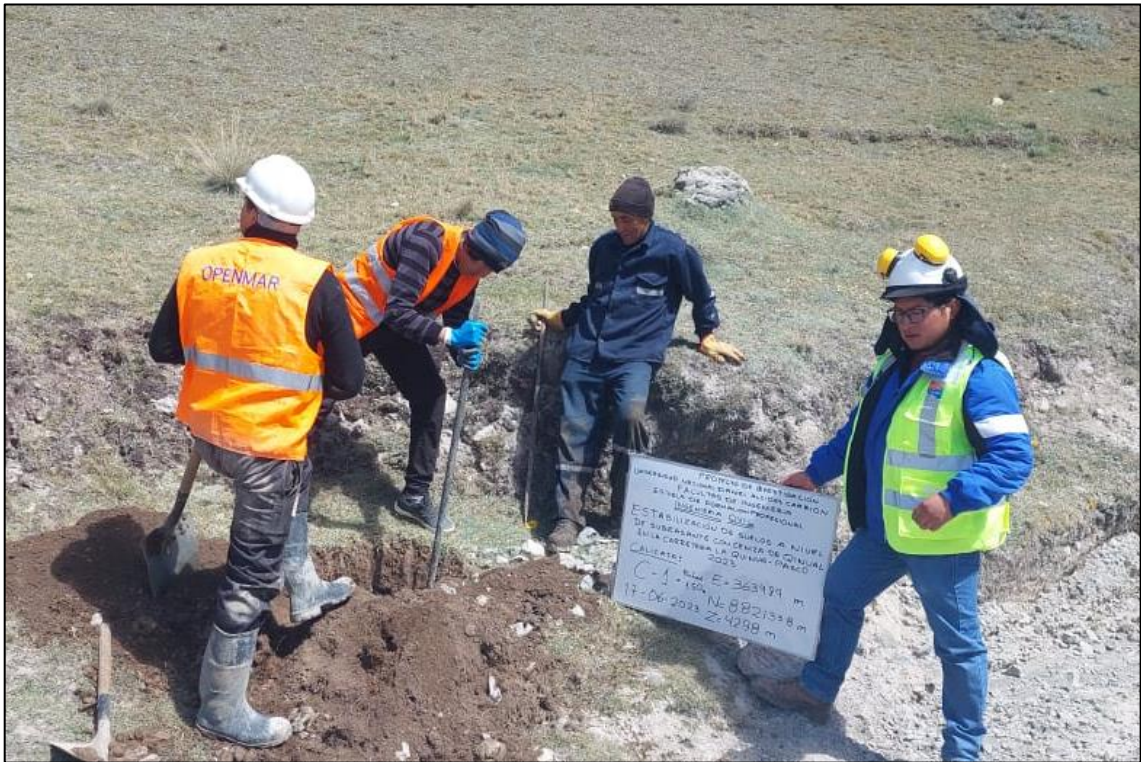
Fotografía 1. Calicata N° 01 - E: 363989, N: 8821338, Z: 4288.
