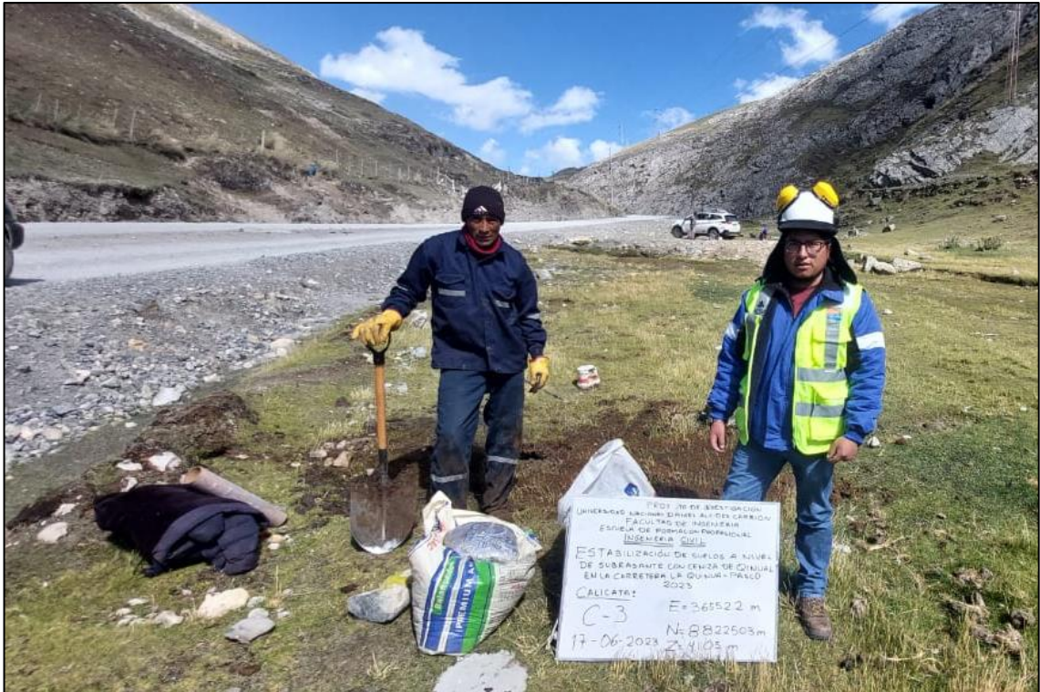
Fotografía 3. Calicata N° 03 – E: 365522, N: 8822503, Z: 4105.
