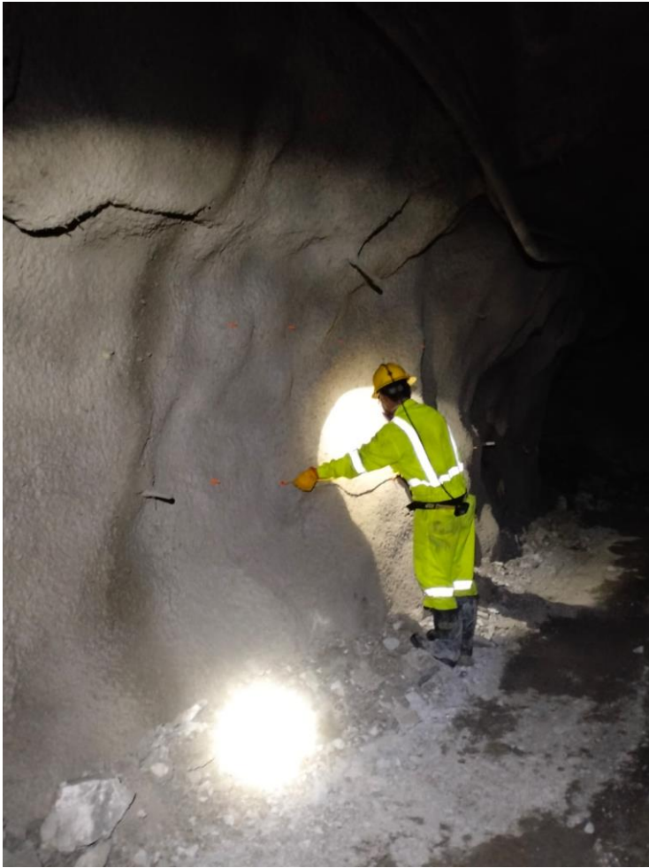
Figura 59. Sostenimiento de la labor usando el concreto lanzado vía seca.
