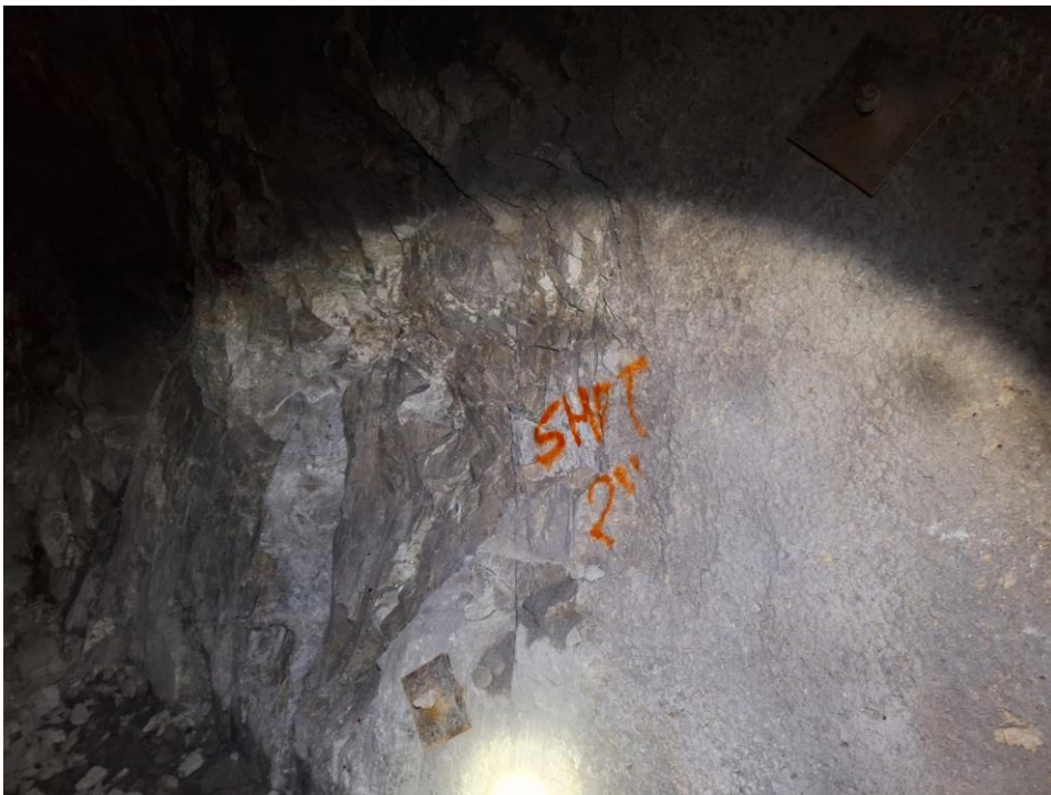
Figura 56. Labor para sostenimiento usando el shotcrete de 2\"/>
