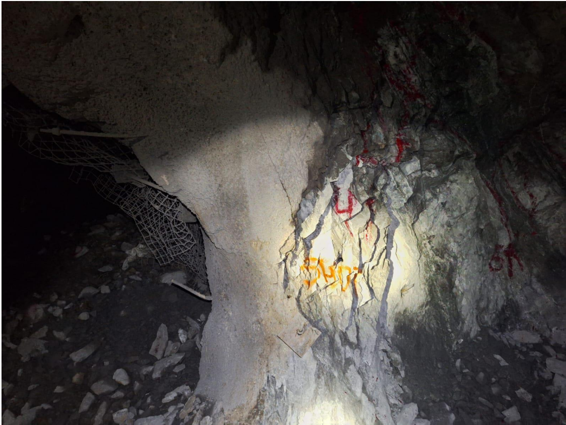
Figura 57. GL 091 para el sostenimiento usando el shotcrete.
