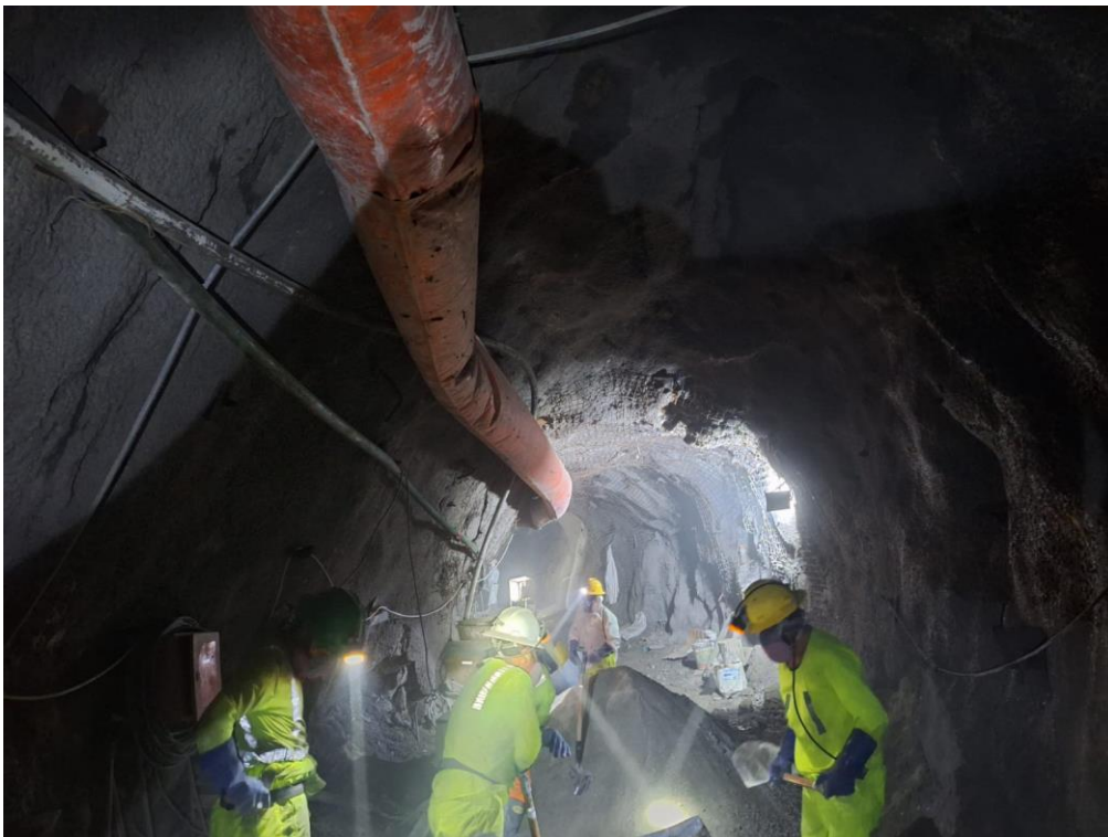
Figura 58. Trabajos de sostenimiento de la GL 091 del Nv. 21 B.
