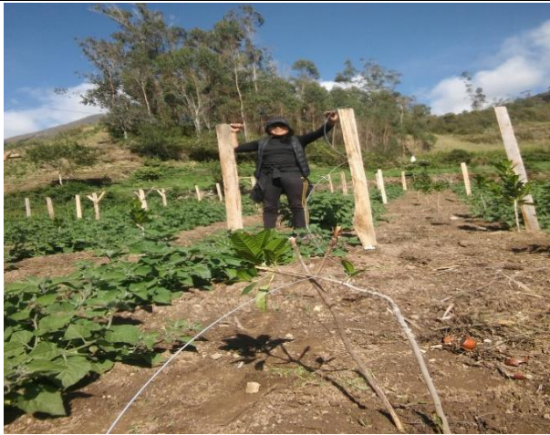
F-63. TENDIDO DE ALAMBRE GALVANIZADO PARA EL TUTORADO
