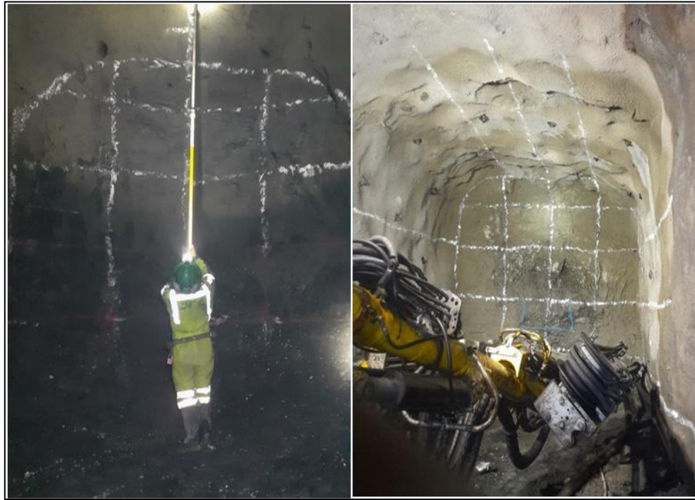
Anexo 18. Perforación del arranque de la nueva malla.
