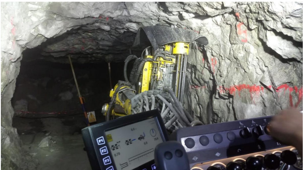
Fotografía 1: Perforación con jumbo
