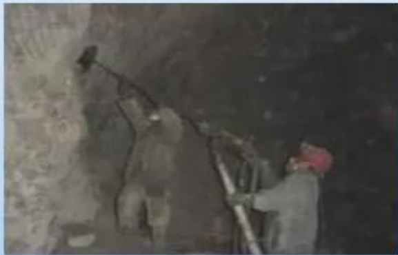
MINERIA SUBTERRANEA TAJEO
