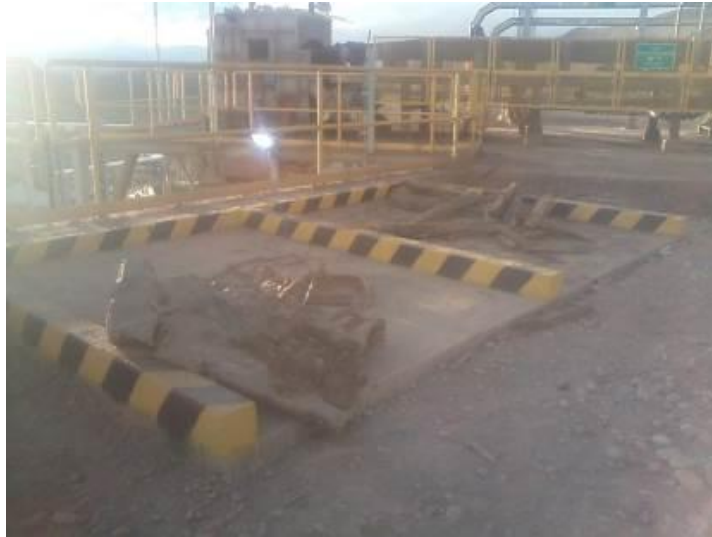
Vista del Punto de Acopio de Chancado Primario Parte Alta – Tajo
