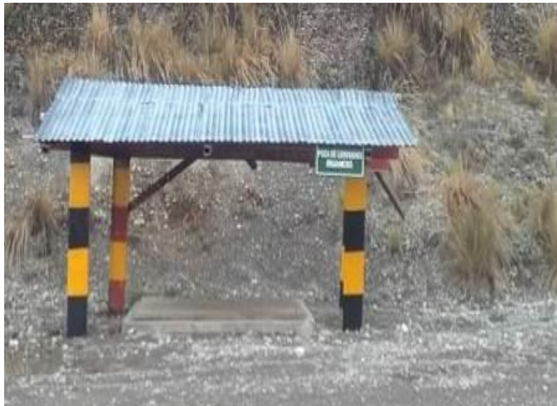
Vista de la Mejora y construcción del sistema de captación de drenajes de lixiviados, canales y poza
