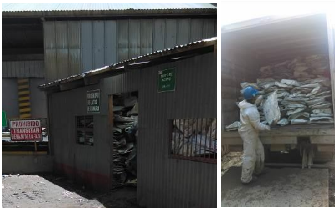
Vista de la caseta de almacenamiento de residuos peligrosos en la planta Celda de residuos peligrosos
