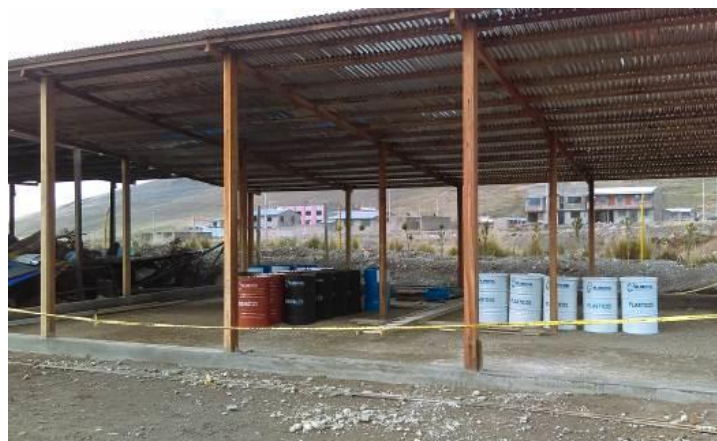
Vista del ingreso al patio de almacenamiento temporal de residuos metálicos.
