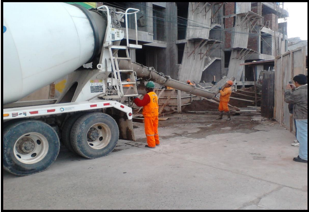
Foto N°11: Puesta en obra del concreto premezclado
