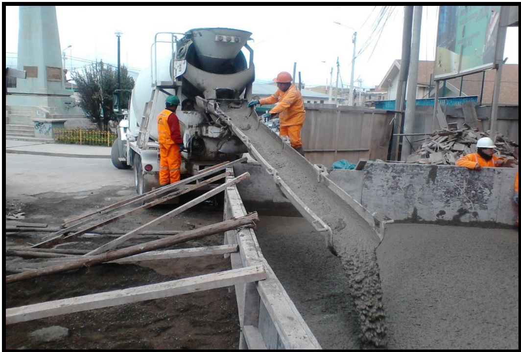
Foto N°12: Puesta en obra del concreto premezclado en Yanacancha.
