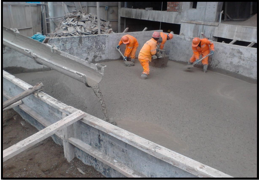
Foto N°13: Puesta en obra del concreto premezclado en Yanacancha.
