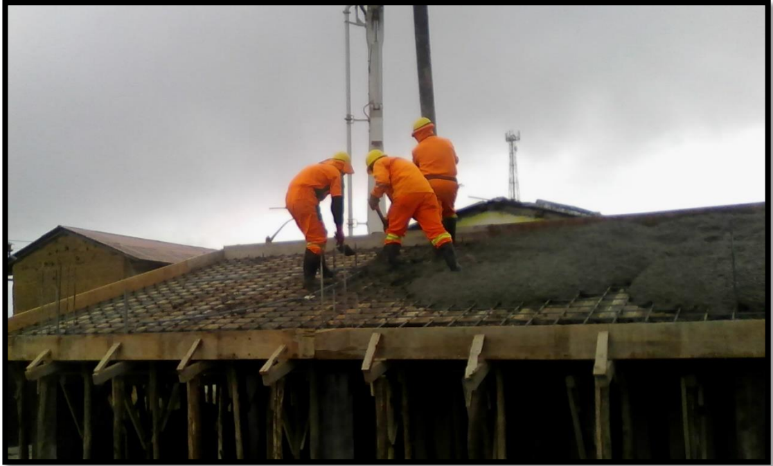
Foto N°15: Puesta en obra del concreto premezclado en Carhuamayo.
