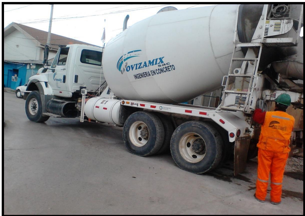
Foto N°10: Puesta en obra del concreto premezclado.
