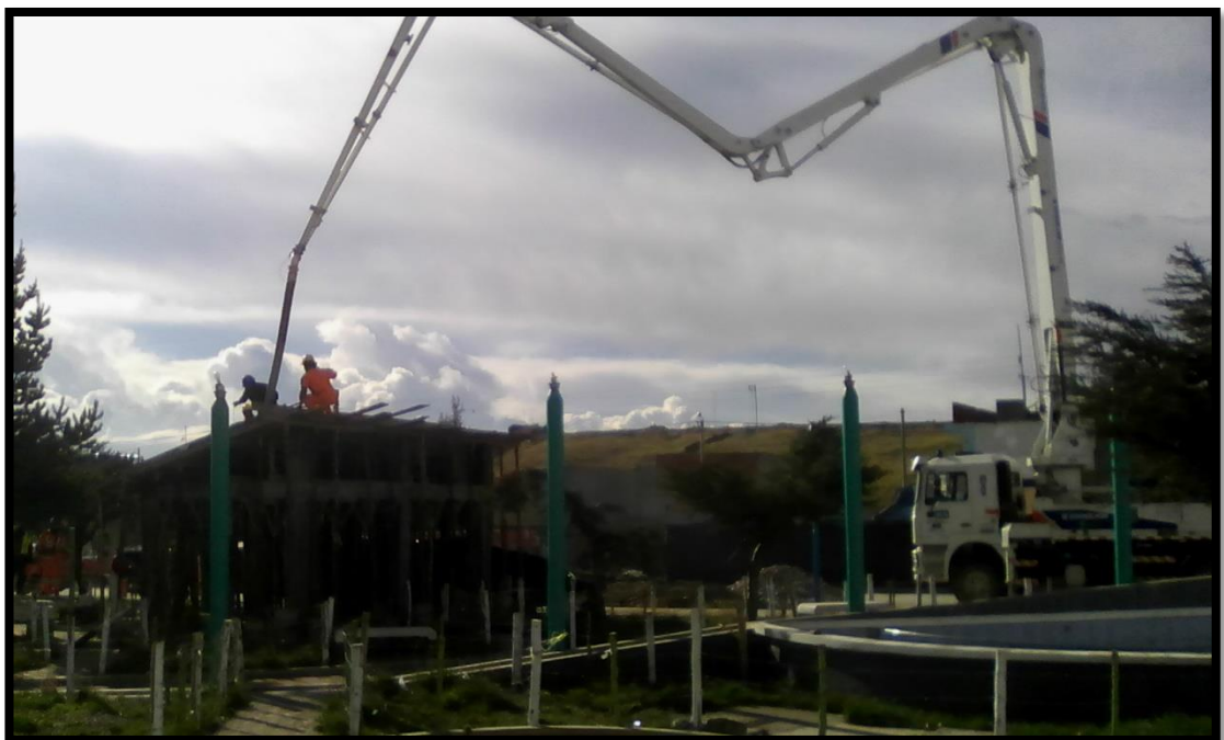
Foto N°18: Vaciado de concreto en Carhuamayo.
