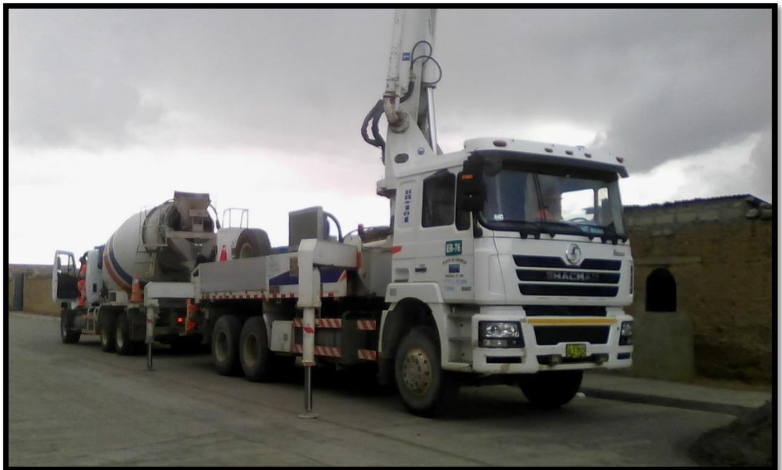
Foto N°16: Camión mixer con bomba incluida.
