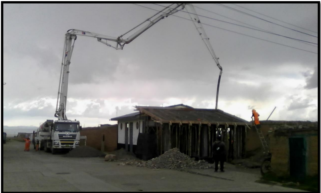
Foto N°14: Puesta en obra del concreto premezclado en Carhuamayo.
