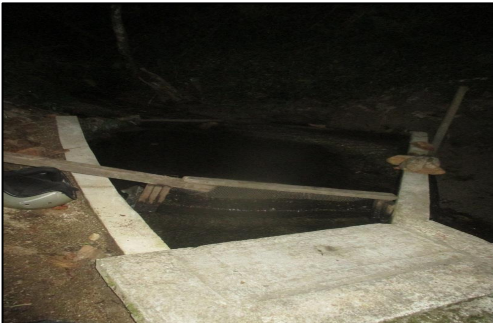
Fotografía N° 7: Captación de la fuente de agua San Roque
