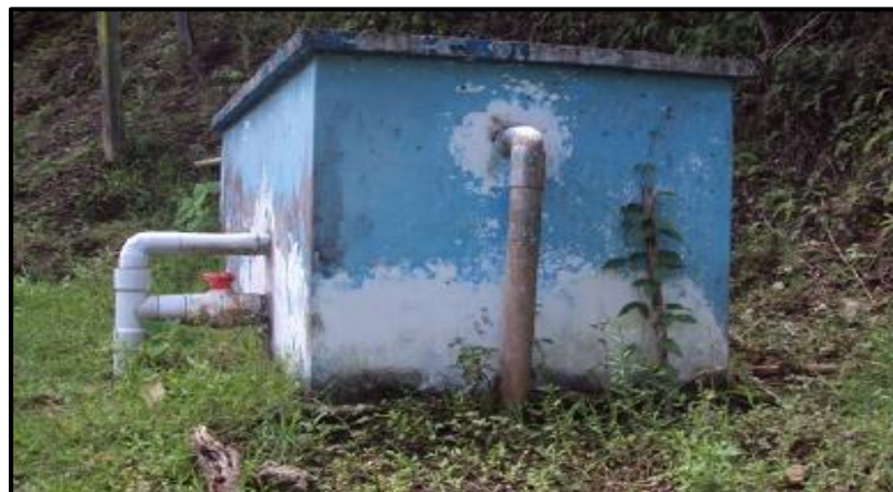
Fotografía N° 2: Estado del reservorio de agua de la CC.NN de Tsachopen - Miraflores
