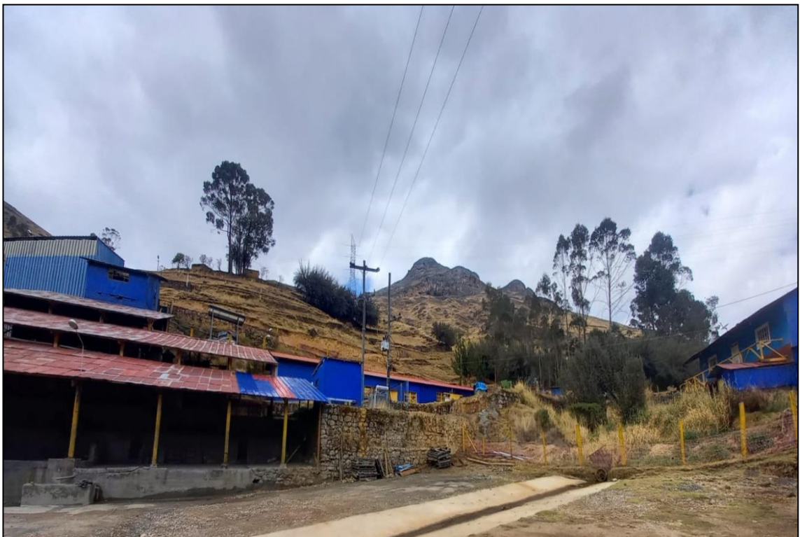
Ilustración 2: Vista Panorámica de la planta concentradora San Sebastián AMC.
