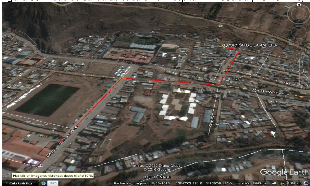
Figura 50: Nodo de salida ubicada en el Hospital 2 - EsSalud (NODO N° 3).
