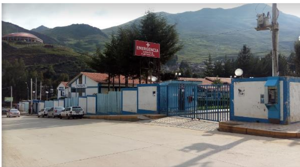
Figura 51: Hospital 2 - EsSalud, Ascención.
