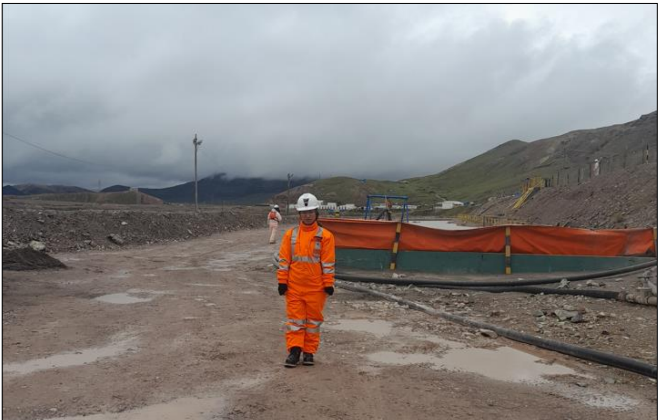
Imagen 006: Visita al relleno hidráulico
