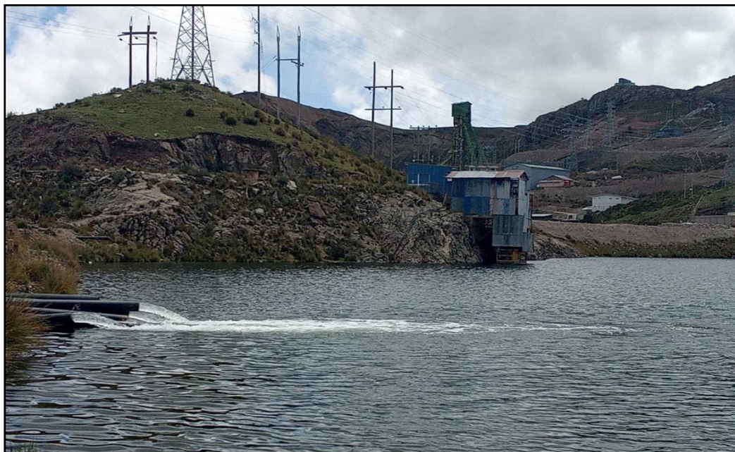
Imagen 3 Vista de la descarga de aguas residuales tratadas a la laguna Naticocha
