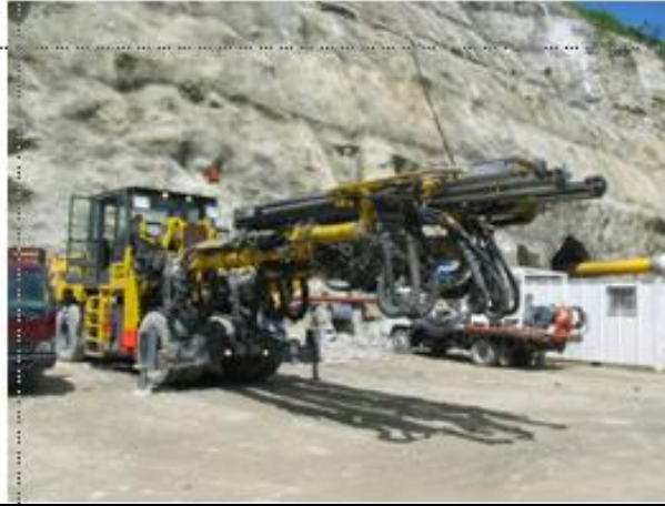
Proyecto Hidroenergético Porce III. Estabilidad de túneles de derivación de aguas, casa de máquinas y piques.
