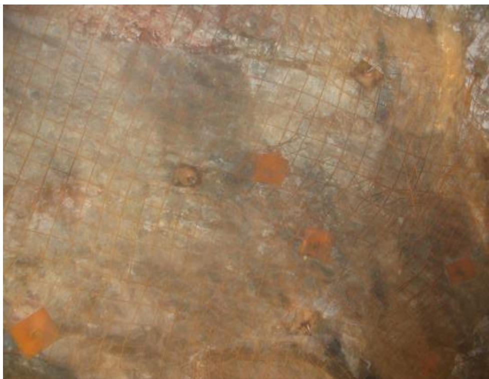
Perno split Set en la Ga 734N Nv. 4152 bien instalado y trabando sobre terreno brechoso
