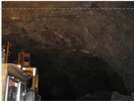
Estabilización de labores temporales con aplicación de equipos robotizados. Equipo Scissor Bolter.
