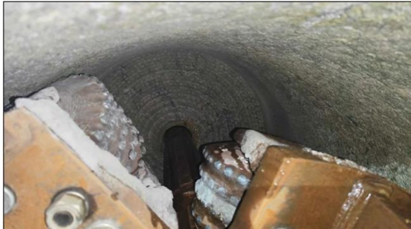
Figura 28 Perforación del Rimado
