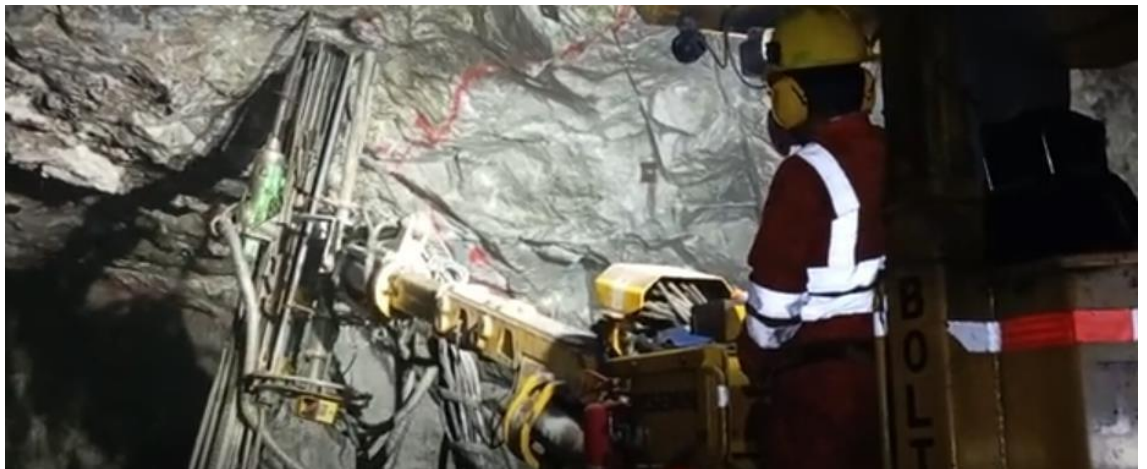
Figura 33 Vista de instalación de perno en una de las labores
