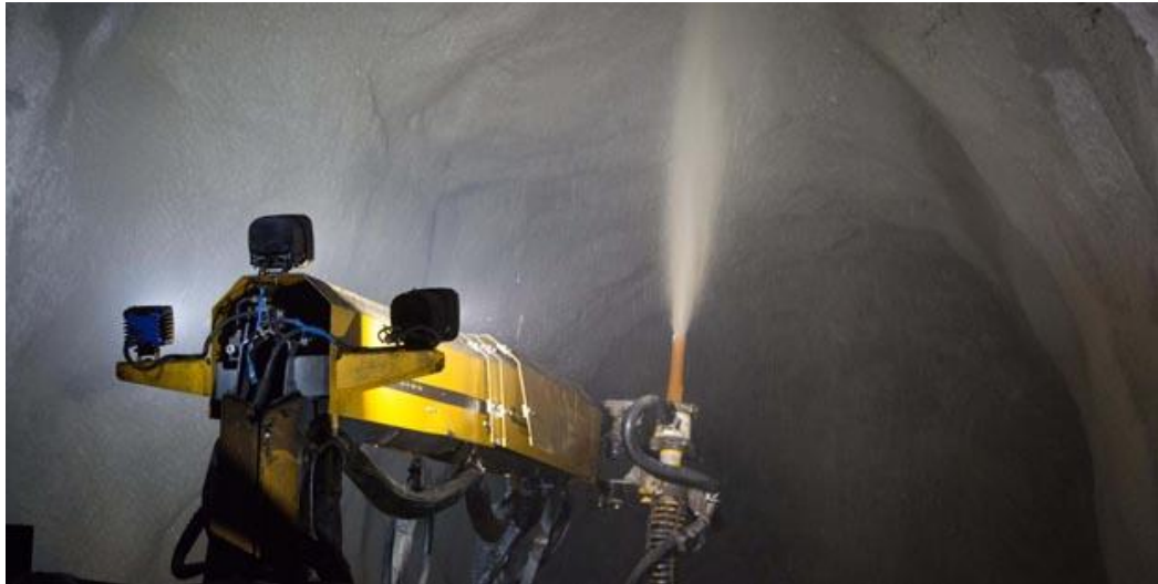
Figura 8 Sostenimiento con Shotcrete con Robot Lanzador
