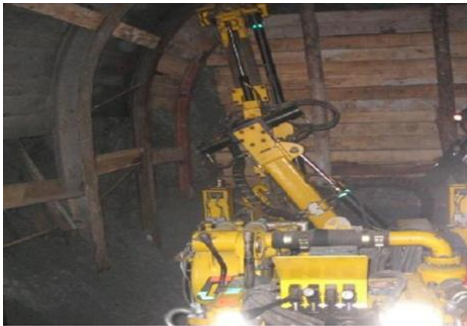
Perforación de taladros para recuperar los pilares de mineral
