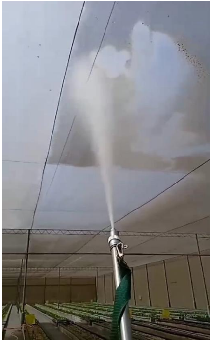
Imagen 9: Lavado de malla del techo en invernadero
