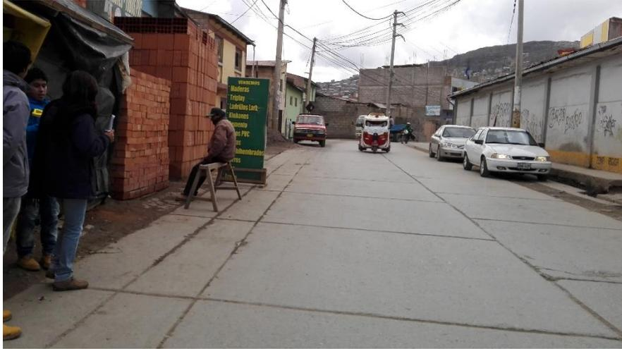
*Figura II.1 Superficie de Pavimento de Concreto Rígido.*
