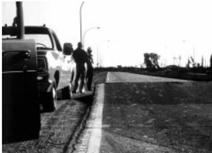
*Figura II.7 Levantamientos pavimentos rígidos de alta severidad.*
