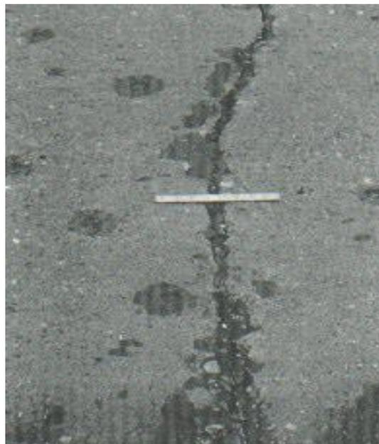
*Figura II.14 Grietas lineales de severidad media en losa de concreto reforzado.*
