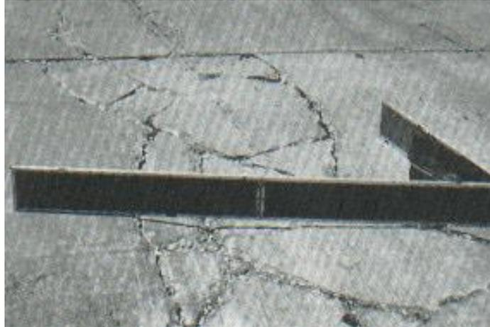
*Figura II.20 Punzonamiento de alta severidad.
