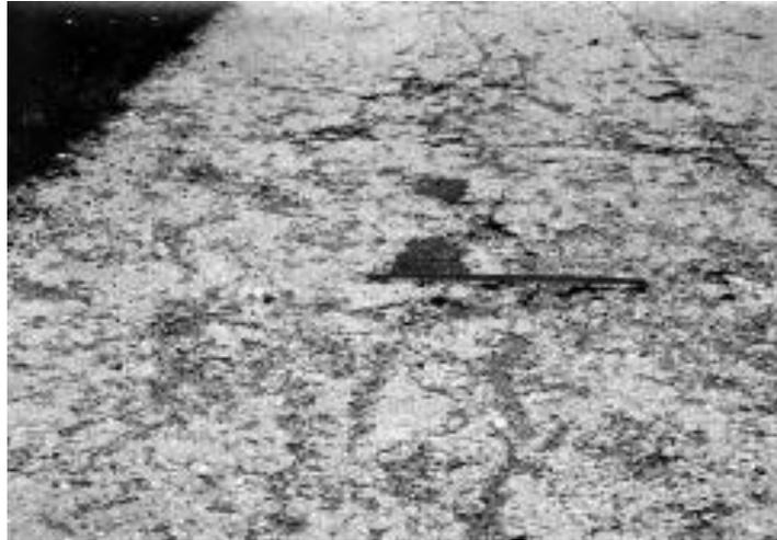
*Figura II.22 Agrietamiento tipo mapeo, Descascaramiento de Alta severidad.*
