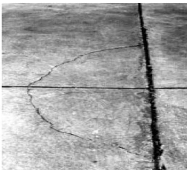
*Figura II.8 Grietas en esquina de baja severidad.*
