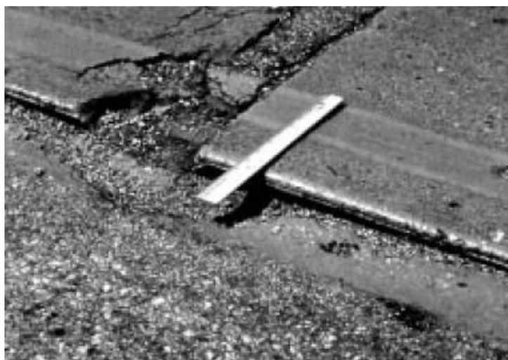
*Figura II.13 Desnivel Carril / Berma de baja severidad.
