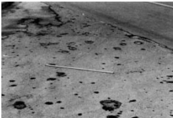
*Figura II.18 Desprendimientos por disgregación de áridos.
