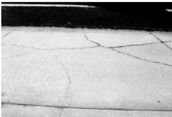
*Figura II.9 Losa dividida de mediana severidad*
