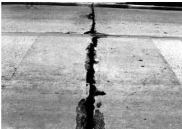
*Figura II.12 Deterioro del sello de la junta mediana severidad.*
