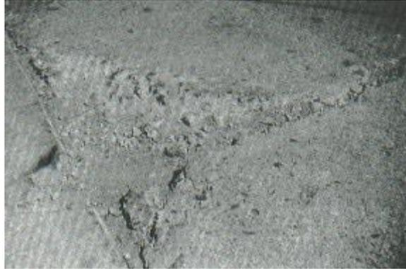
*Figura II.24 Descascaramiento de esquina de alta severidad.
