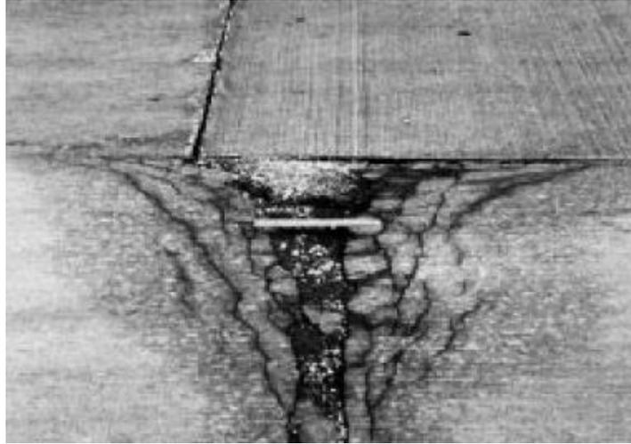
Figura II.10 Grietas de Durabilidad de mediana severidad.
