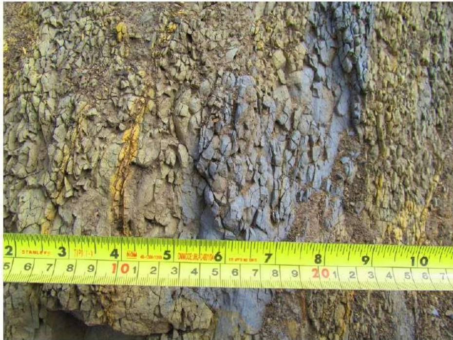
Figura 38. Limonita deleznable expuesta en talud generado por la excavación de la fundación
