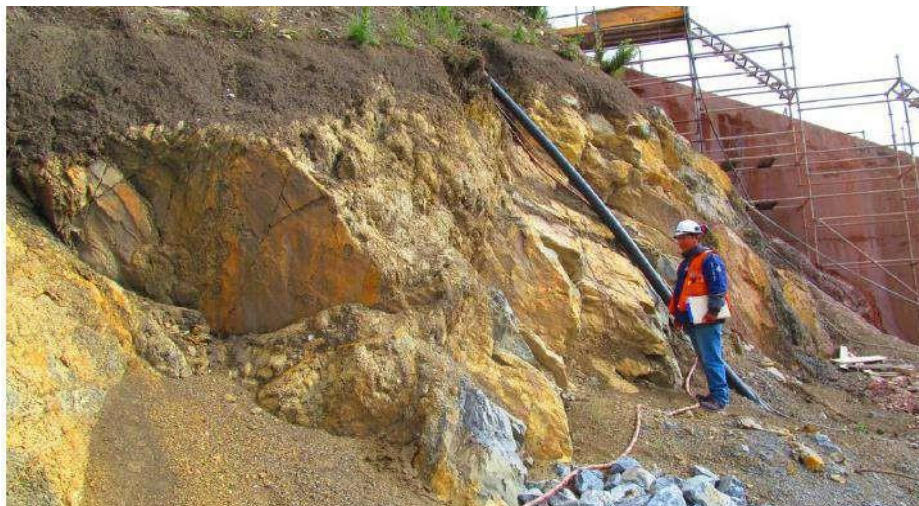
Figura 50. Derrame recurrente de lechada ubicado hacia aguas abajo del plinto
