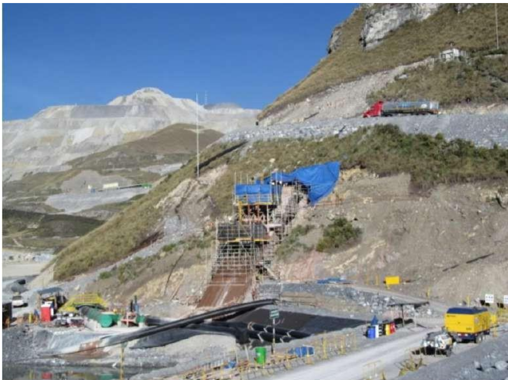
Figura 34. Vista panorámica del estribo izquierdo mostrando las plataformas instaladas sobre el plinto
