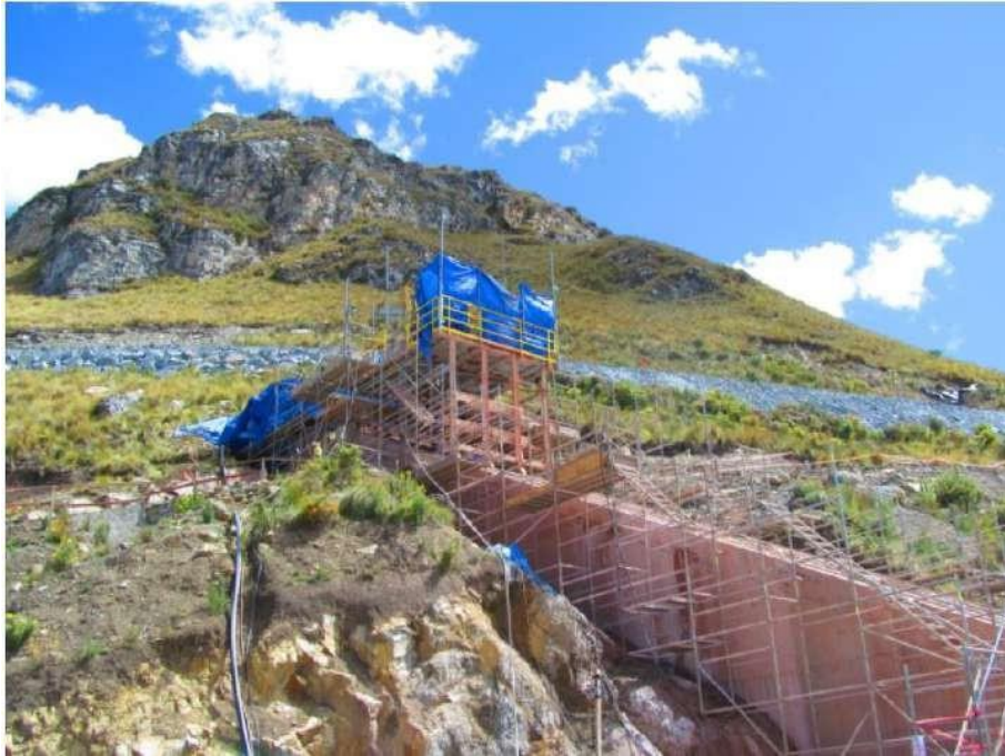
Figura 35. Costado de aguas arriba del plinto que ilustra la inclinación del mismo
