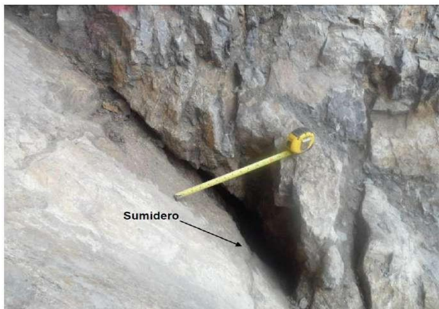
Figura 31. Muestra la geometría del sumidero kárstico que aceptó un caudal de 60 L/min a gravedad
