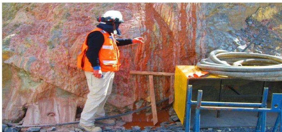
Figura 50. Derrame recurrente de lechada ubicado hacia aguas abajo del plinto
