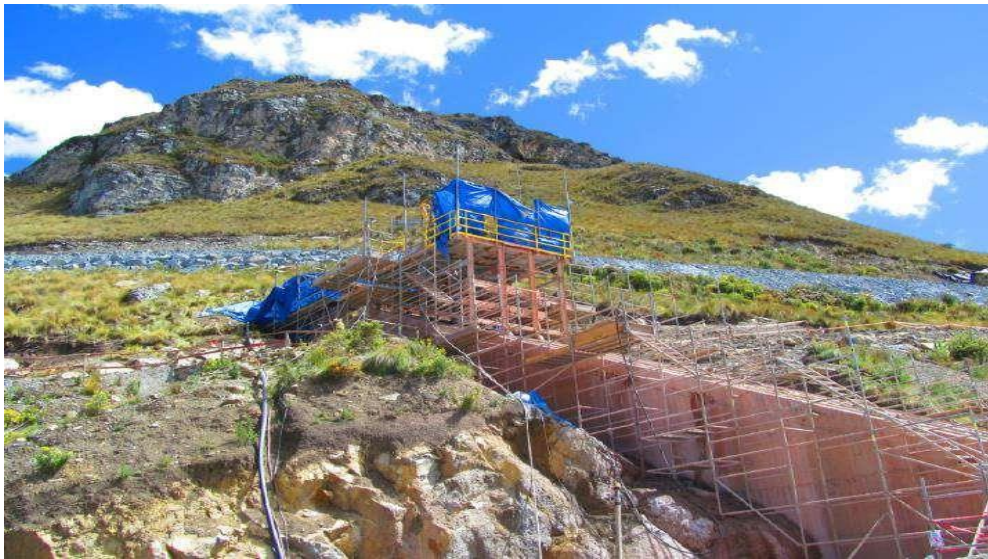
Figura 19. Plataforma móvil estacionada en la parte superior del plinto izquierdo
