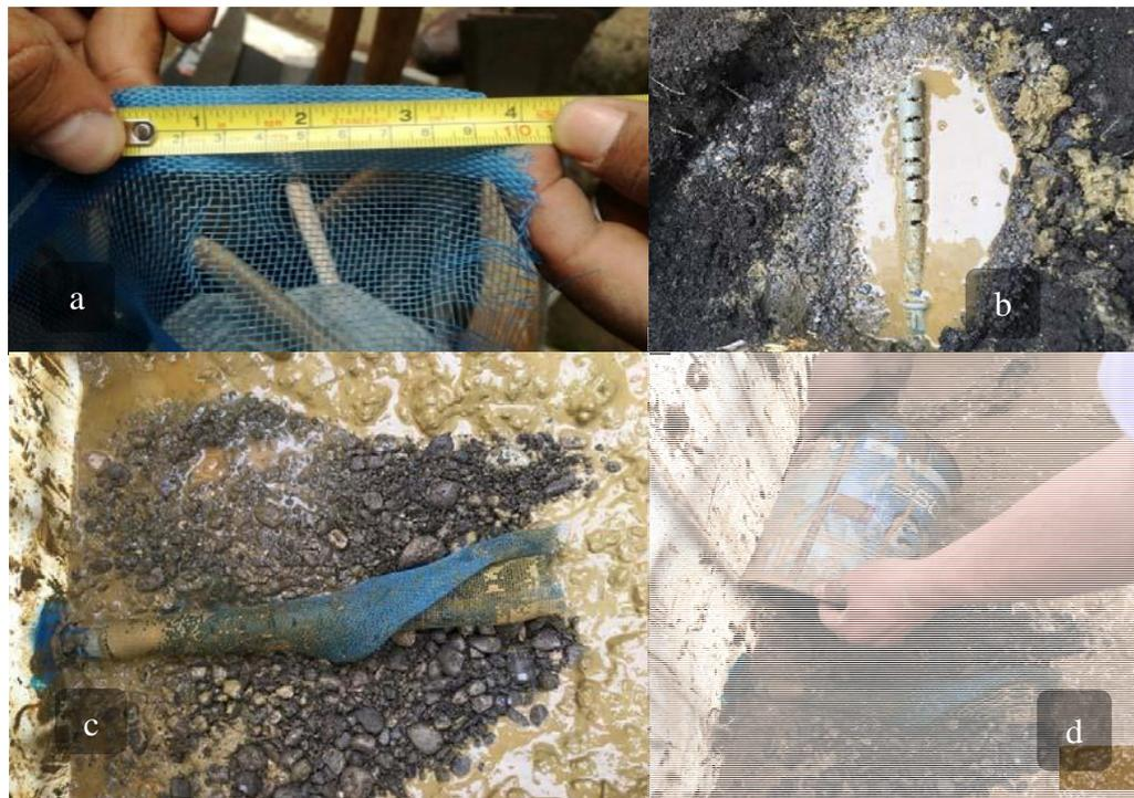
**Notas:** a. Malla plástica; b. tubo PVC de ½” ranurado; c. y d. Instalación de la piedra y arena gruesa. Fuente: WSP, 2018
