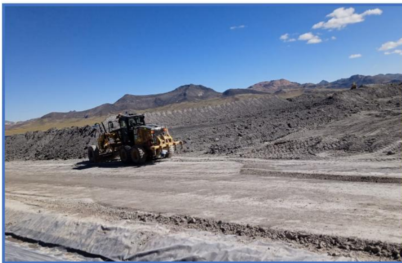
Figura 31 Mantenimiento de vías
