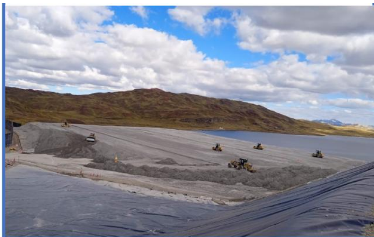
Figura 19 Adecuación de la mezcla para conformación de capas
