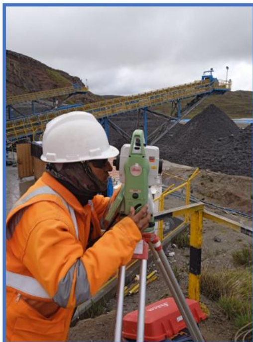
Figura 30 Control topográfico de la plataforma de la relavera
