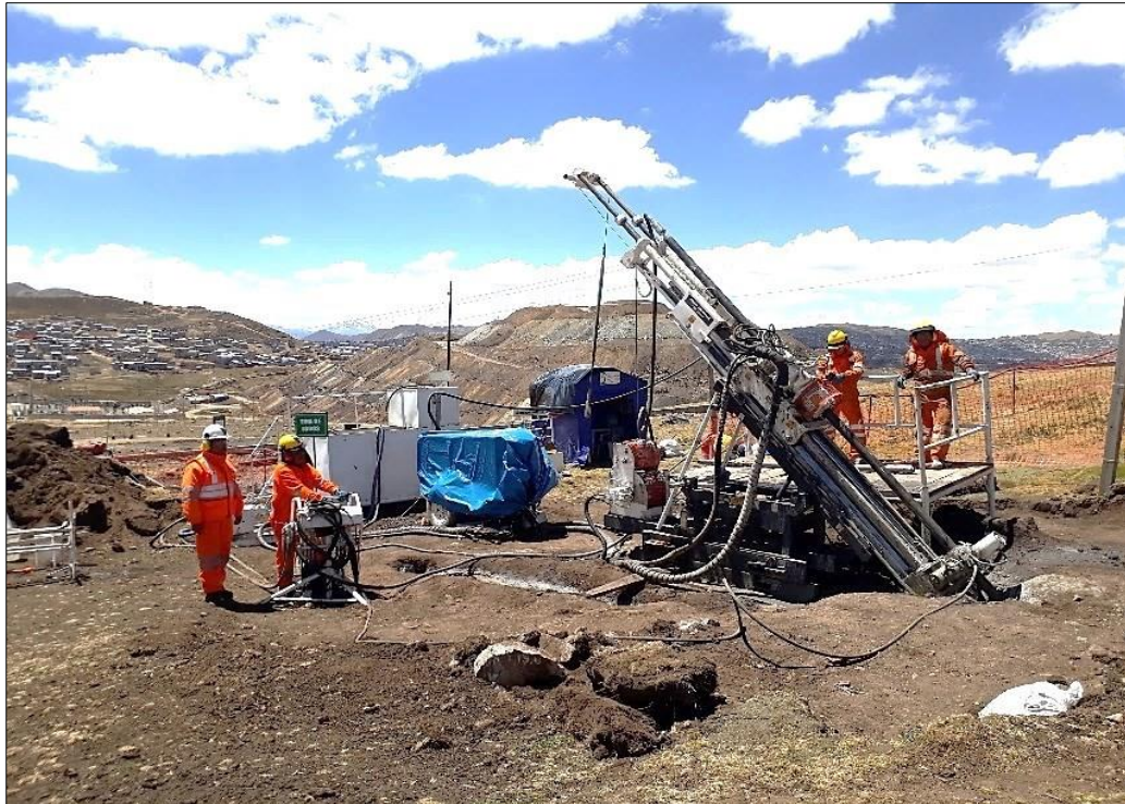
Fotografía 1 Trabajos de Perforación Prospecto minero Cerro Shuco - Simón Bolívar, Pasco.
