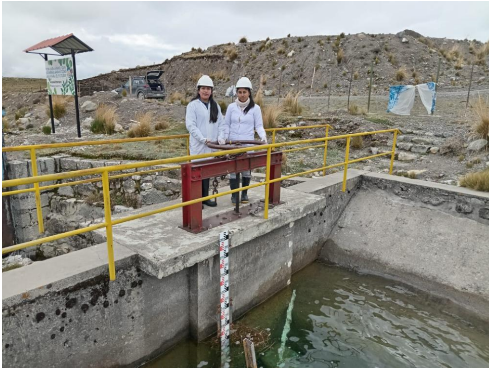
Zona donde se tiene la compuerta para regular la salida del agua
