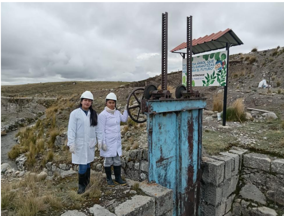
Zona donde se tiene la compuerta para regular la salida del agua
