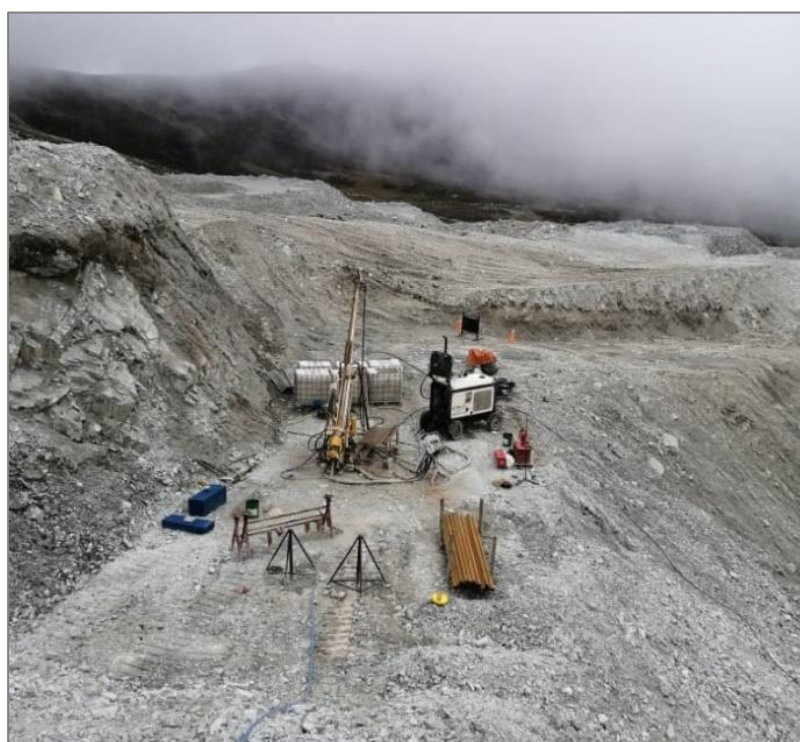
Figura 39. Superdrill N300D en operación
