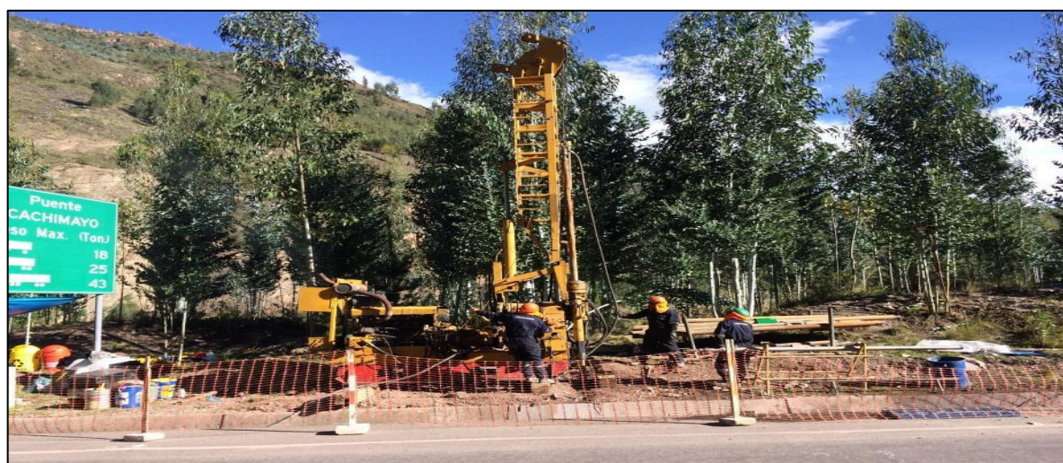
Foto 11. Identificación de los sondeos S-01 y S-02 del Puente Cachimayo
