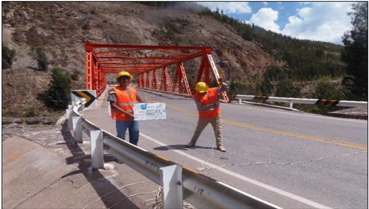
Foto 17. Línea sísmica LS-07. Puente Cachimayo.
