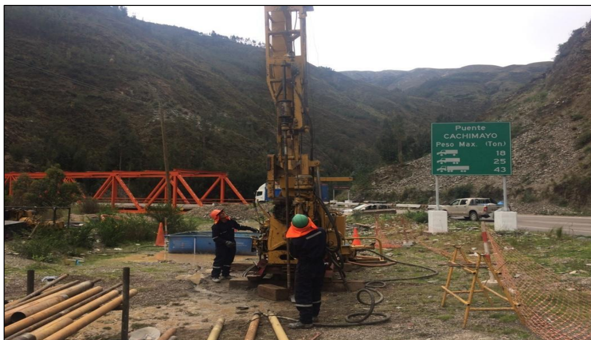
Foto 13. Ensayo realizado en el Sondeo S-02 en el Puente Cachimayo
