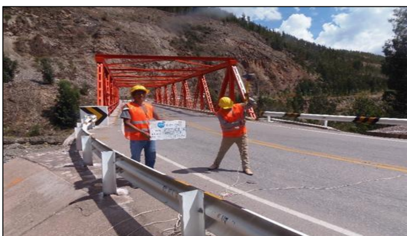
Foto 21. MASW-07. Puente Cachimayo.
