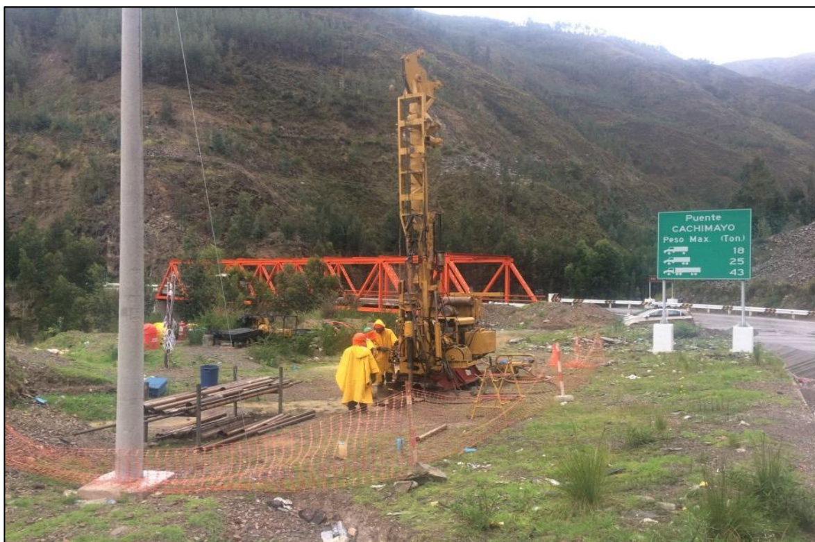
Foto 12. Sondeo S-02. Puente Cachimayo.
