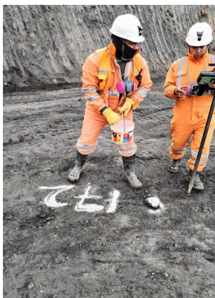
Figura 9 Marcado de vértices de la malla de perforación
