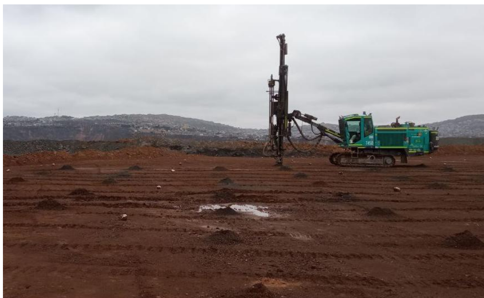
Figura 17 Inspección visual de los conos
