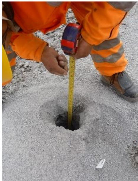
Figura 26 Medición de profundidad de los pozos perforados
