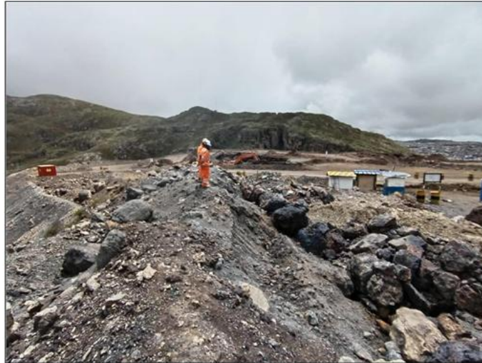
Figura 100 Verificación y coordinación para habilitar sectores sin perforación BH.
