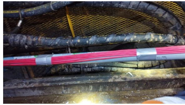
Encintado de cables metro a metro
