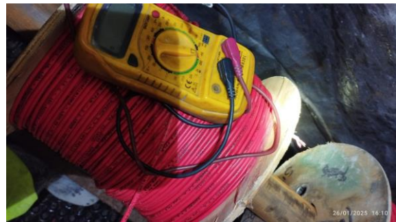
Medición de continuidad antes, durante y después
