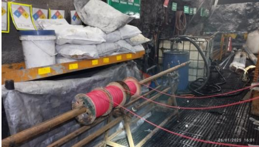
Instalación de cable al tubo guía
