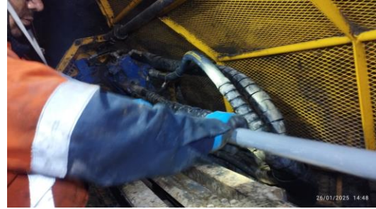
Colocación de carretes
