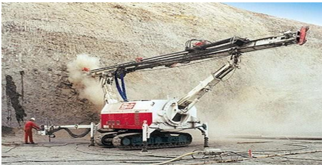
Figura 17 Paraguas de micropilotes en boquilla exterior.
