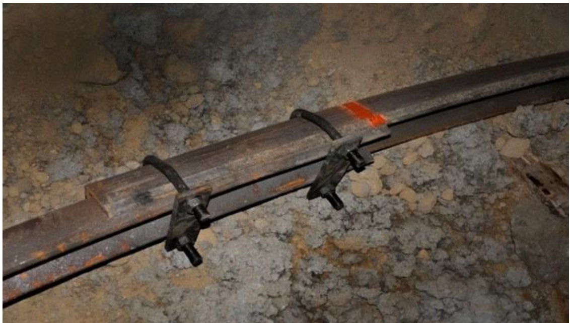
Figura 7 Sistema de apriete con grapas en perfiles TH.
