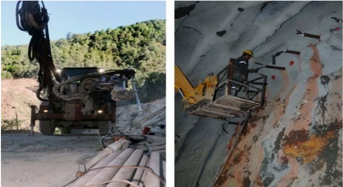
Figura 15 Jumbo y micropilotes.
