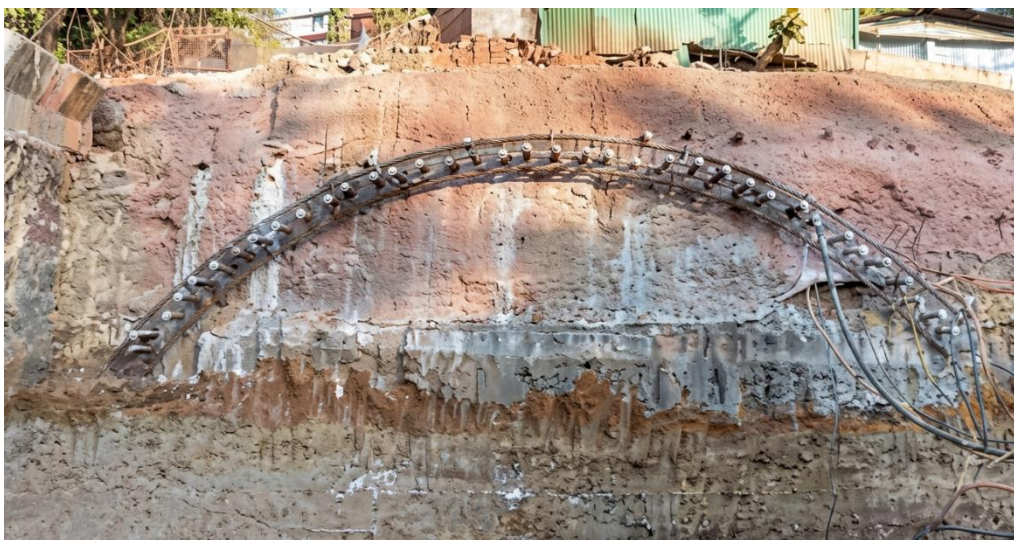
Figura 13 Enfilaje pesado, apoyado sobre una viga de atado
