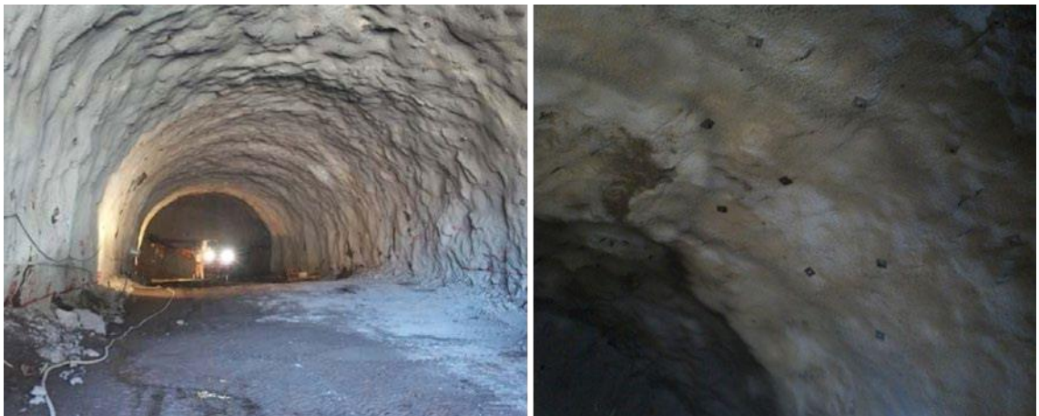
Figura 4 Instalación de anclaje tipo Swellex, Túnel Frijolar, carretera Durango-Mazatlán.
