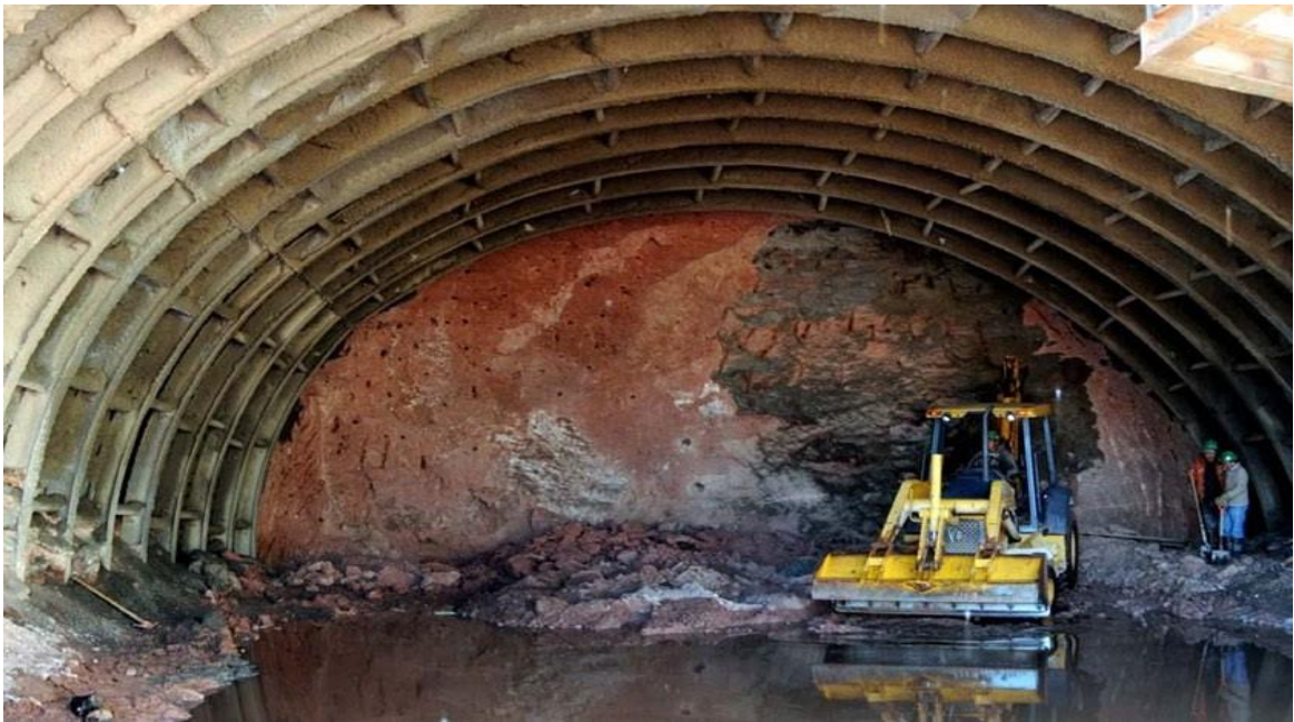
Figura 5 Marcos metálicos IPR pesados retacados con hormigón.
