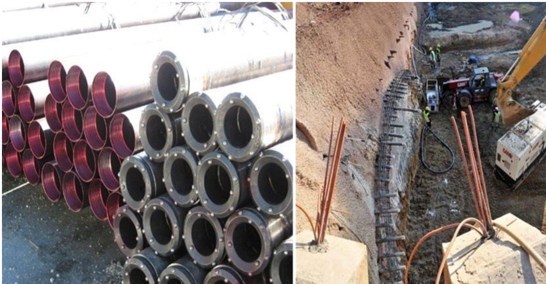
Figura 18 Enfilaje autoperforante.
