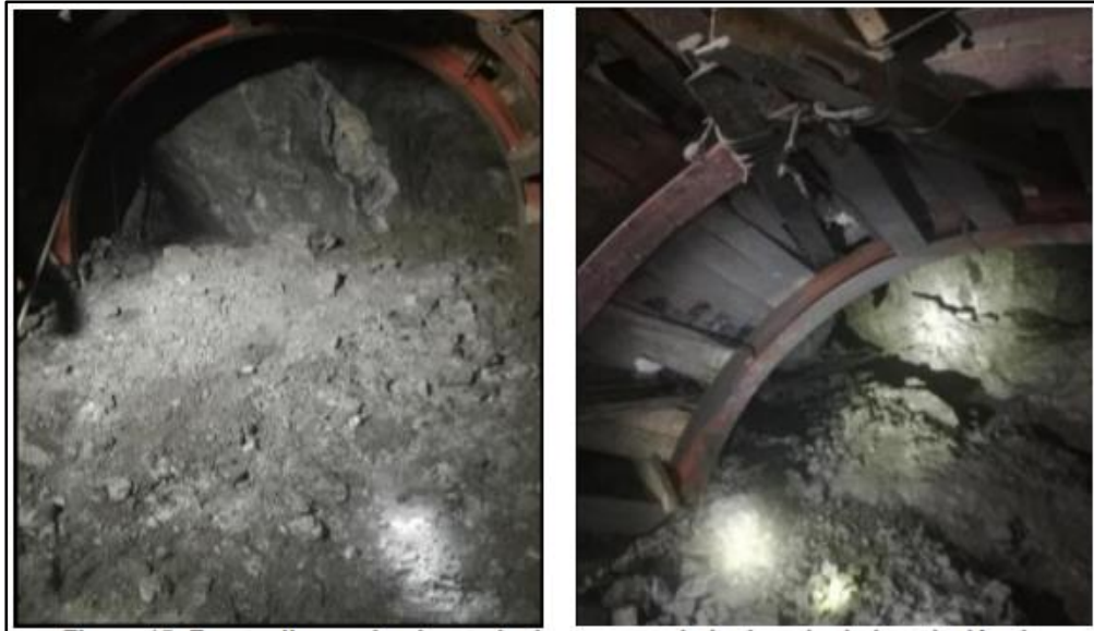
Figura 8. Frente disparado, desatado de rocas y a lado derecho la instalación de marchavantes de 45/60lbs. 6 a más
