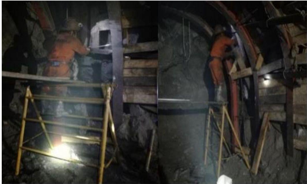
Figura 10. Iniciando el entablado, cariito y topes. A la derecha el encribado de cimbra, bolsacretes, bancos y materiales
