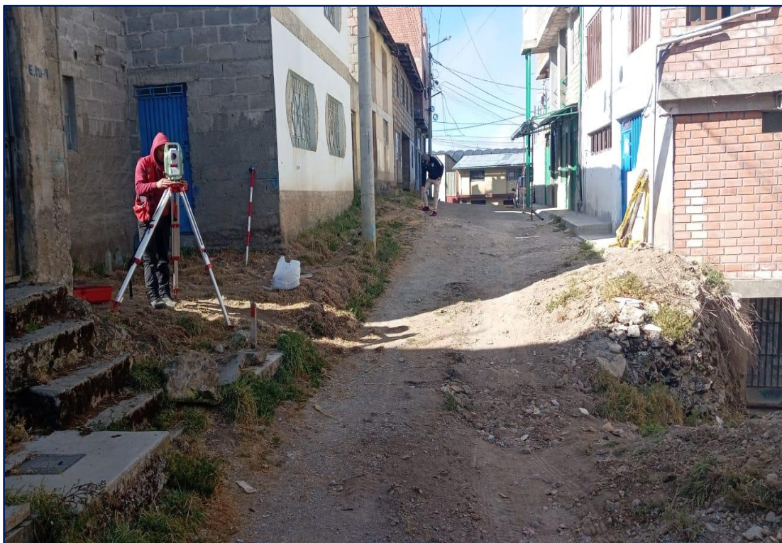
Figura 7. Trazo y replanteo topográfico con estación total.
