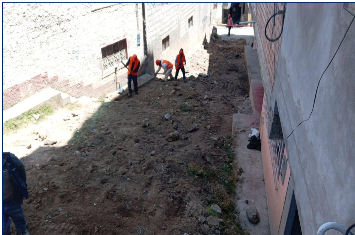
Figura 4. Trazo y replanteo del ancho de la calzada.
