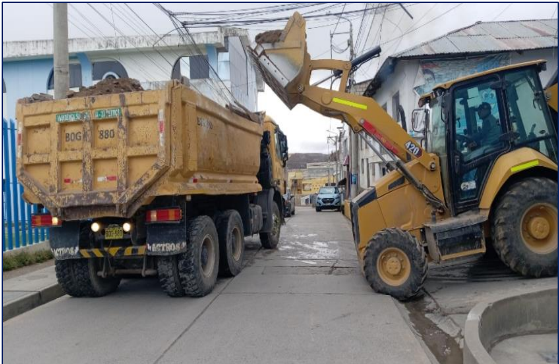
Figura 2. Carguio del material excedente para su eliminación con retroexcavadora 420 F2 Cat
