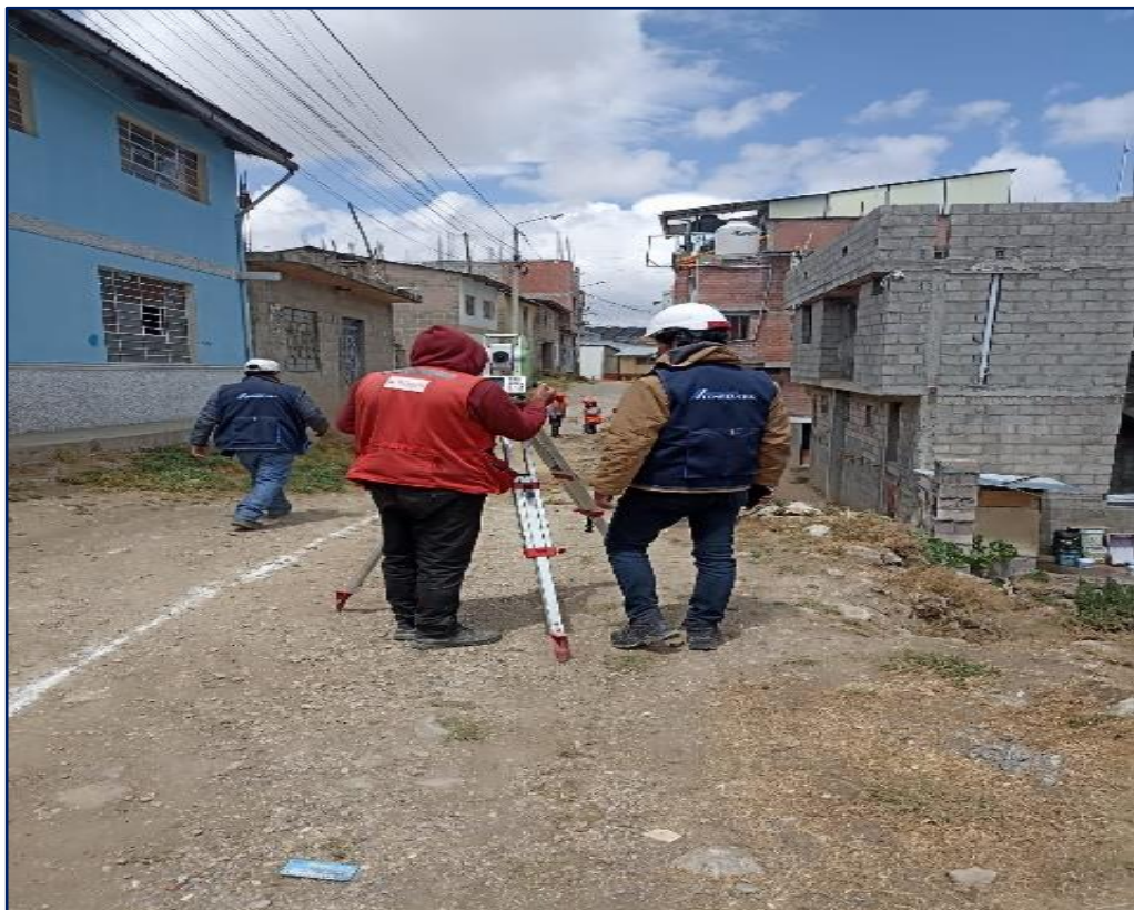
Figura 9. Trazo del eje de la calzada con estación total.
