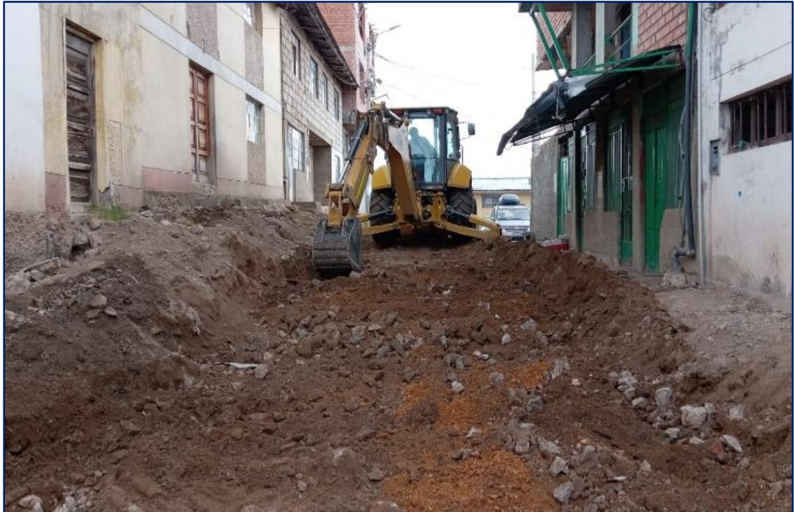
Figura 18. Eliminación de la grava para el tendido de la cama de apoyo.
