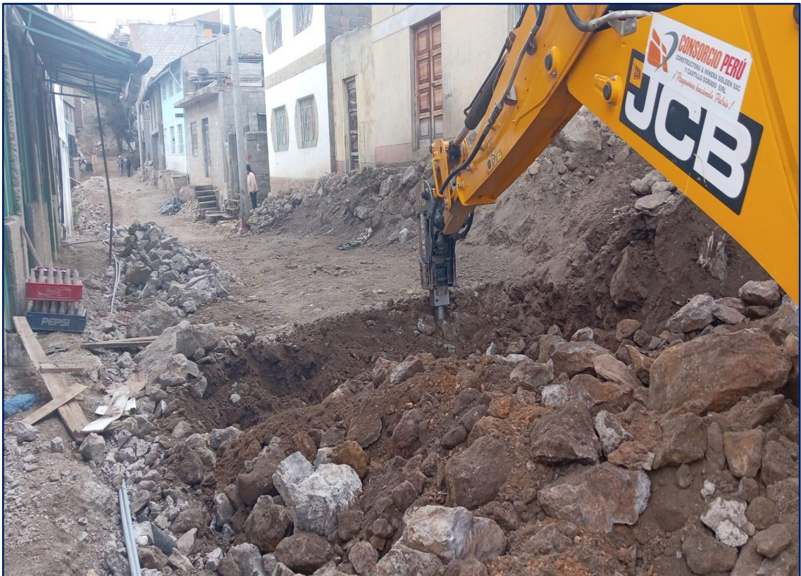
Figura 3. Corte del material con retroexcavadora 420 F2 Cat, para su eliminación.
