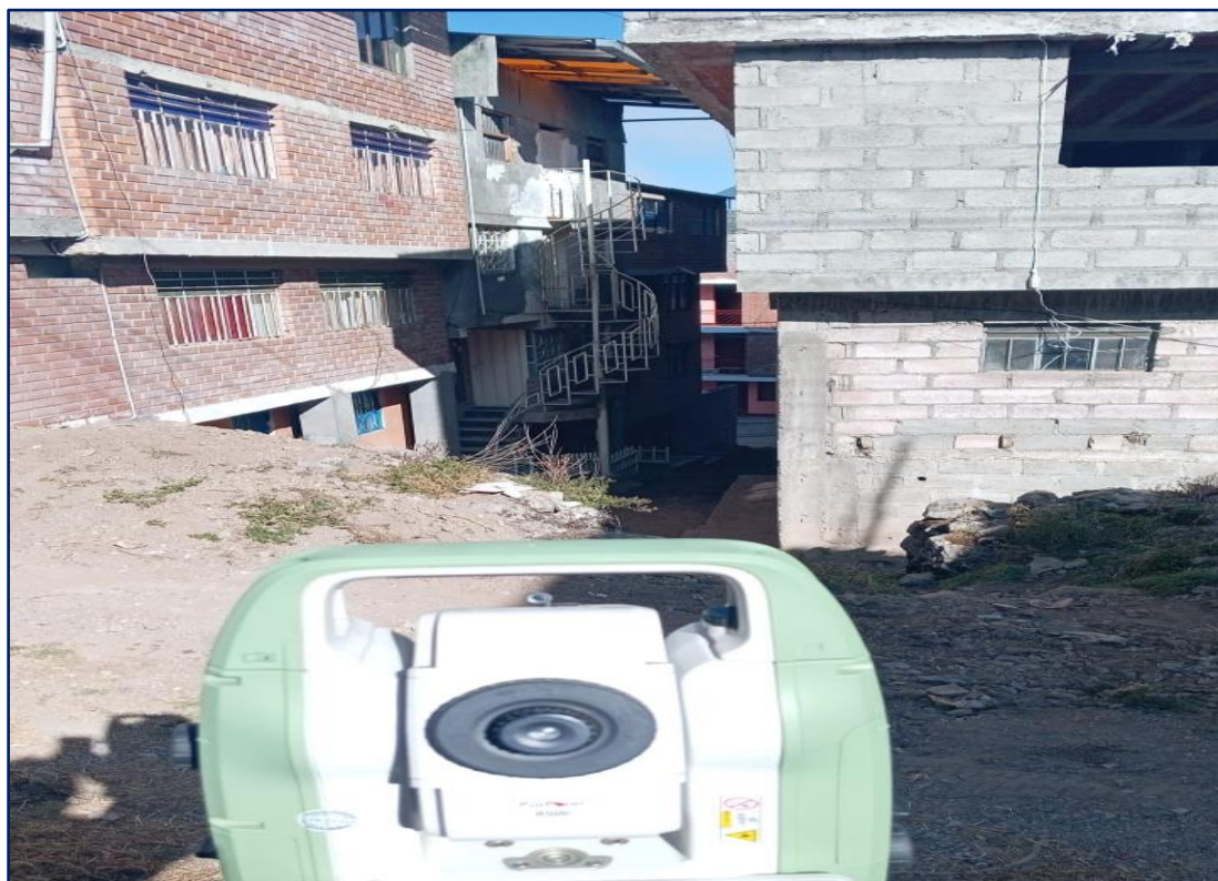
Figura 8. Replanteo topográfico con estacion total en la calzada.
