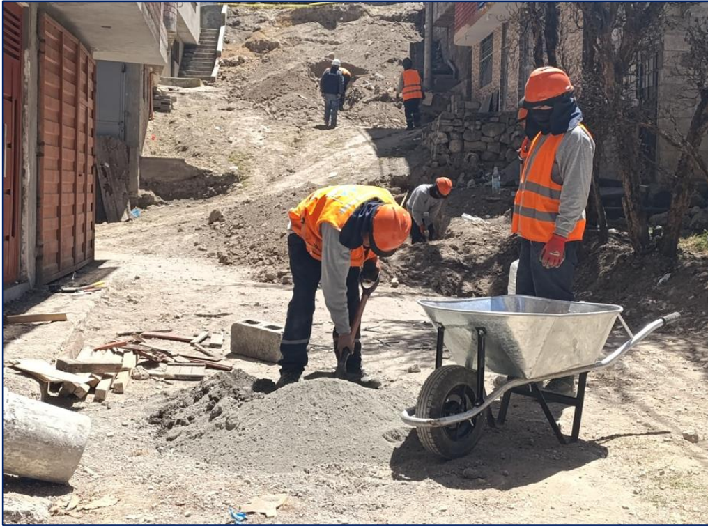
Figura 17. Preparación de la mezcla para el vaciado del buzo de desagüe
