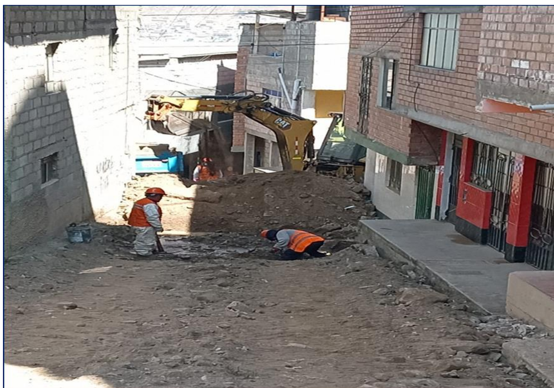
Figura 11. Corte del terreno natural con la retroexcavadora 420 F2 Cat.
