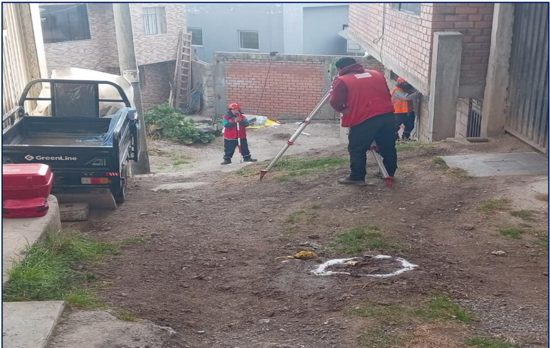
Figura 19. Trazo y replanteo topográfico con estación total, para la calzada, vereda y cuneta
