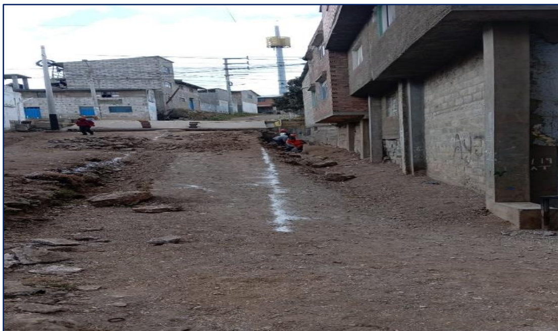
Figura 10. Trazo con yeso del ancho del carril en un sentido de la vía
