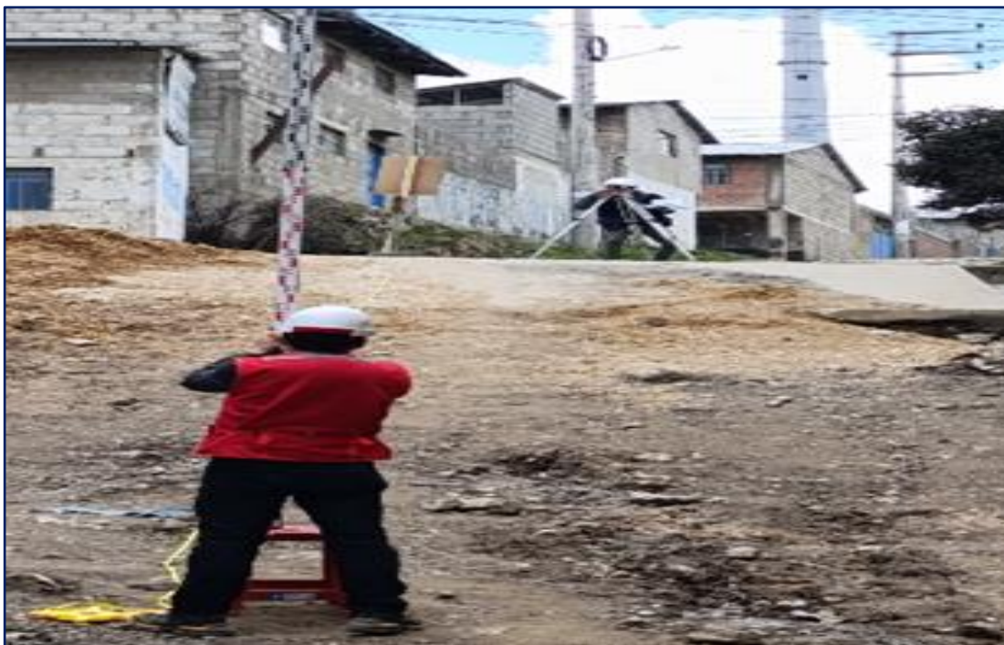
Figura 13. Nivelación del terreno con la mira topográfica
