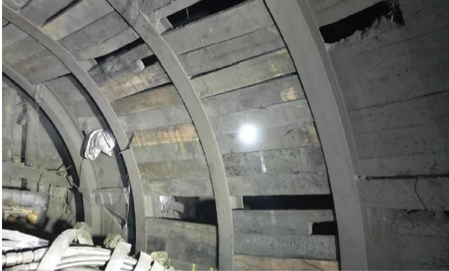
Entablado del slot derecho V7 - F2/F3 - Tajo piloto
