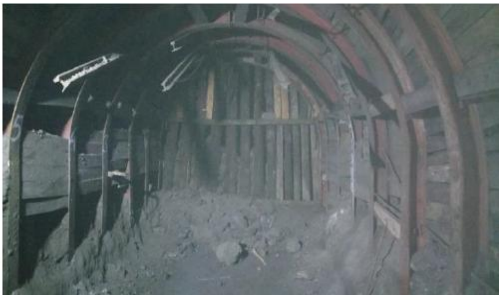
Ventana 8 Piso 16 Nv. 970 – Esperanza
