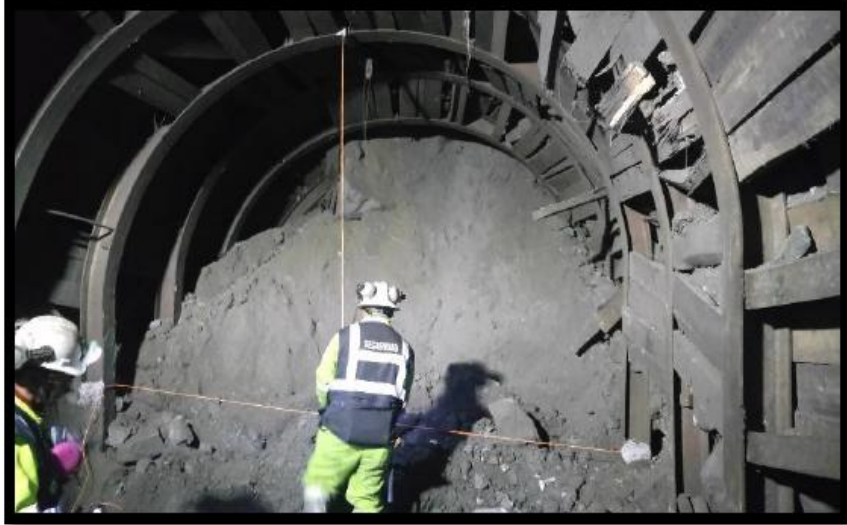
Figura 17. Plasteo de cimbras – Esperanza Norte Nv 920 Piso 8.
