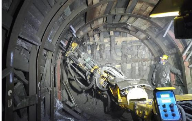
Perforación Slot Izquierdo – V8 Inicio de Turno 03/11.
