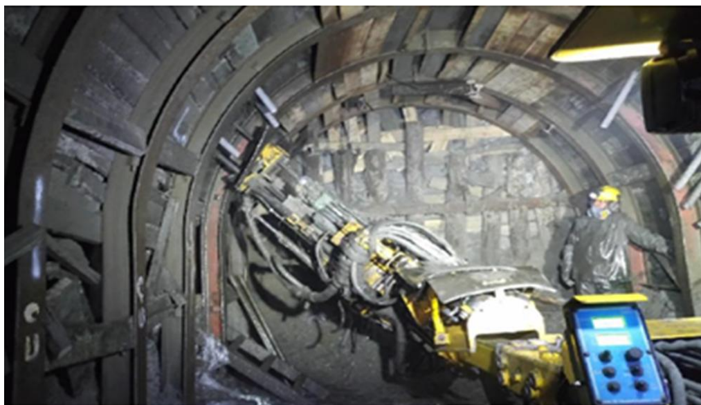
Perforación Slot Izquierdo – V8 Inicio de Turno 03/11.
