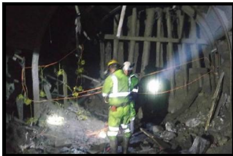
Carguío y amarre de taladros bolsillos slot lateral izquierdo Fila 1-2-3 Ventana 7.
