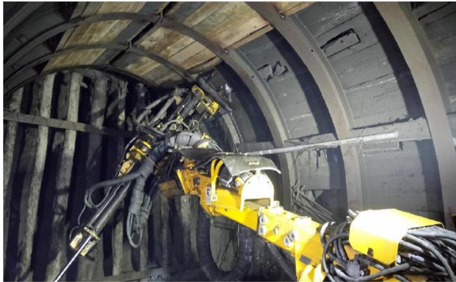
Perforación de Rimados superiores Slot derecho - Fila 2
