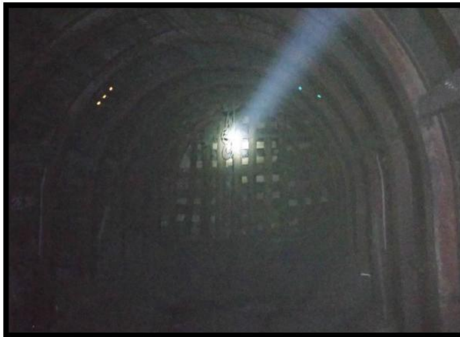
Figura 22. Culminación de la preparación de la ventana 9
