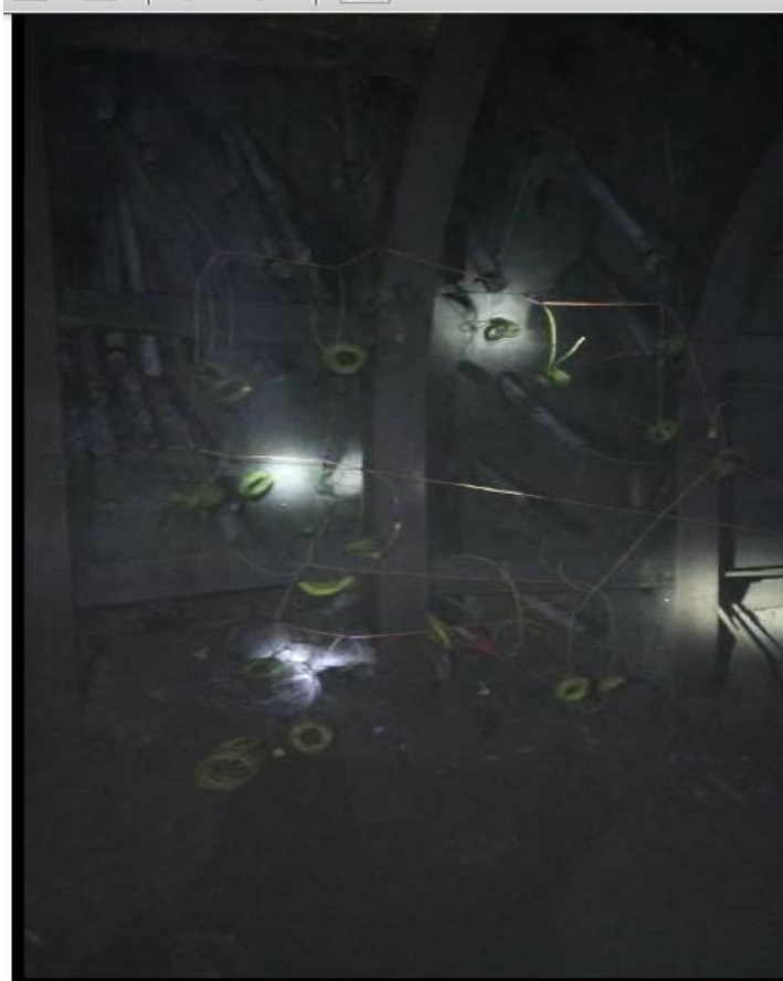
Carguío y amarre de explosivos – Ventana 7 Tajo piloto
