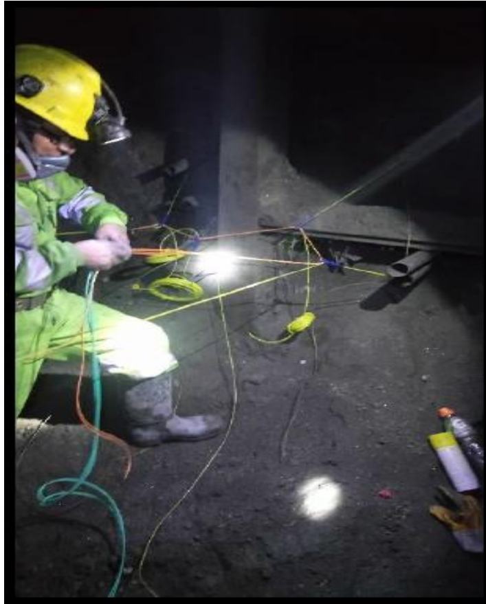
Plasteo de tiros cortados – Ventana 7 Tajo piloto
