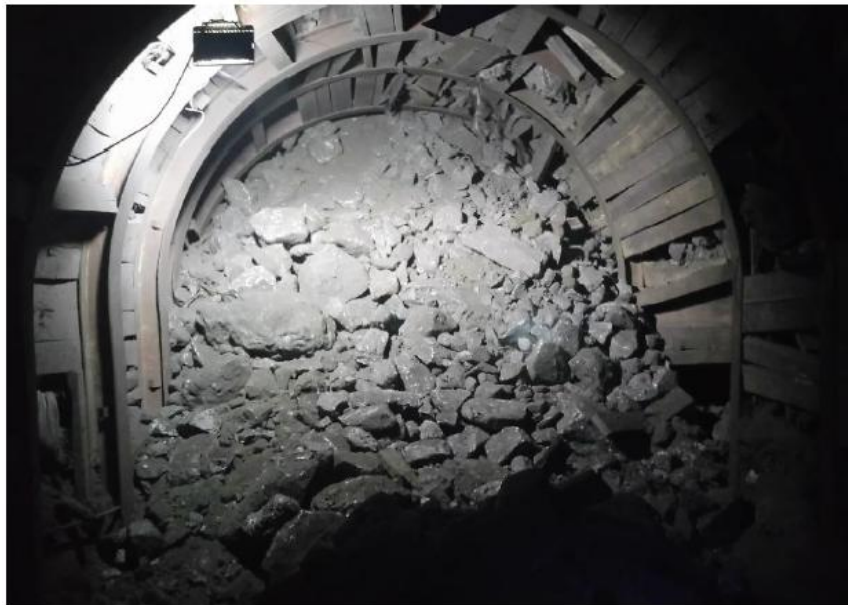
Figura 18. Resultado del plasteo de cimbras – Esperanza Norte Nv 920 Piso 8.
