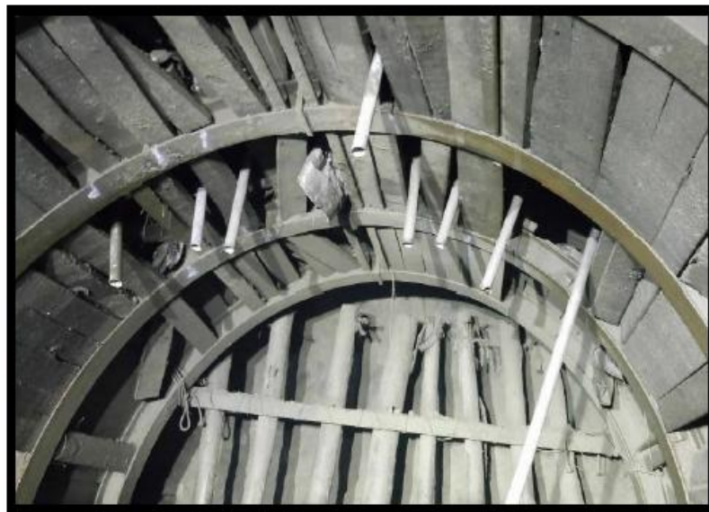
Acumulación de taladros corona Fila 2 Ventana 7.
