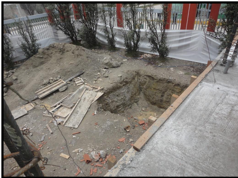
Fotografía N° 8: El terreno es rocoso, no está acorde con el estudio de suelos.
