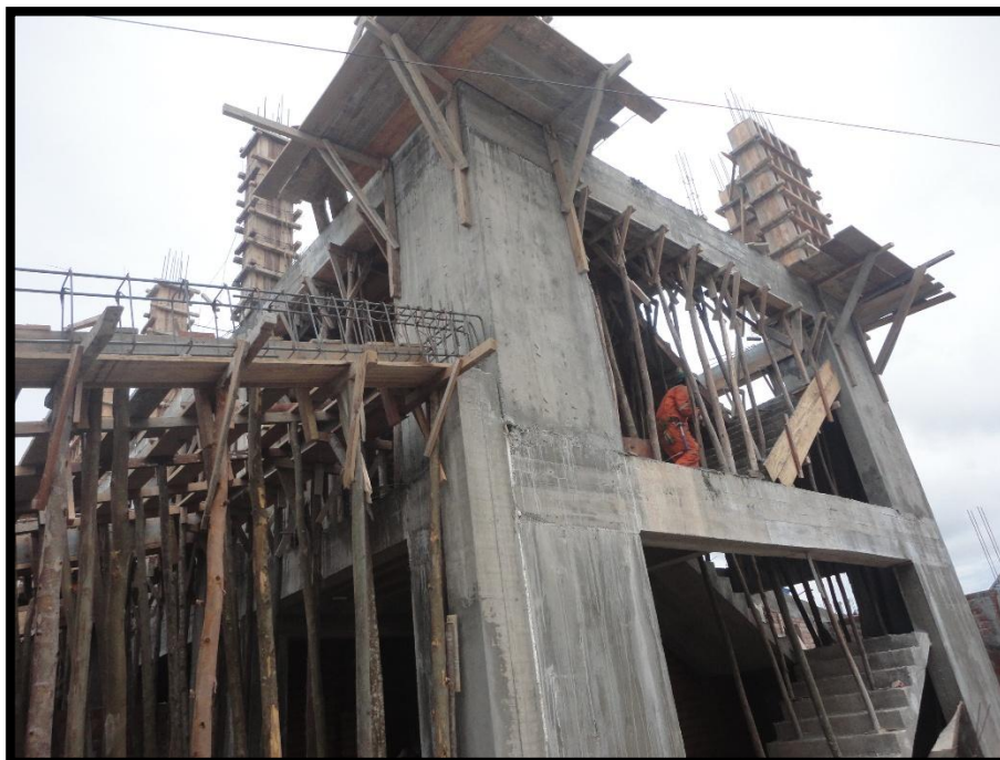
Fotografía N° 9: Se aprecia parte de la estructura de la edificación.
