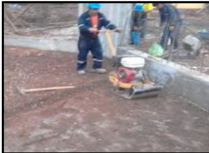
Fotografía N° 2: Trabajos de Mejoramiento de terreno.
