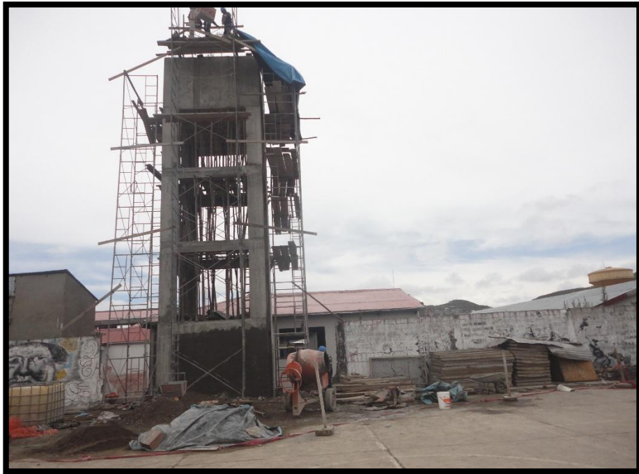
Fotografía N° 13: Se aprecia la construcción de un tanque elevado
