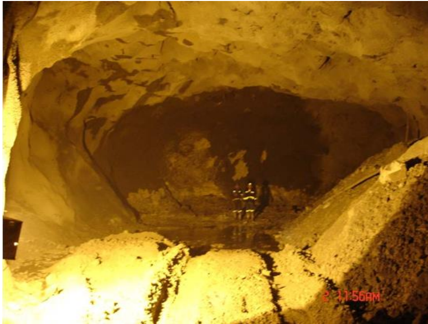
Figura 24: Sostenimiento temporal de Tajos amplios, con Shotcrete y pernos de compresión.
