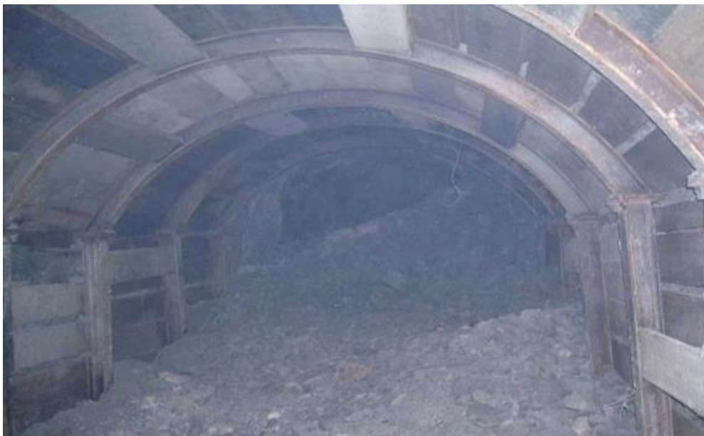
Figura 49: Cimbras Metálicas para labores Críticas.
