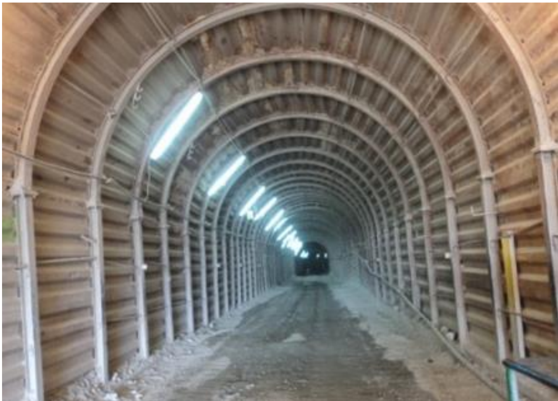
Figura 47: Labor Minera con Cimbras Metálicas y Planchas acanaladas.
