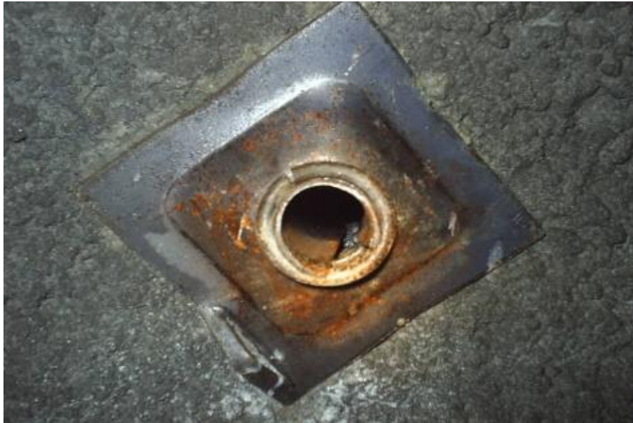
Figura 43: Placa de reparto del "Split Set".
