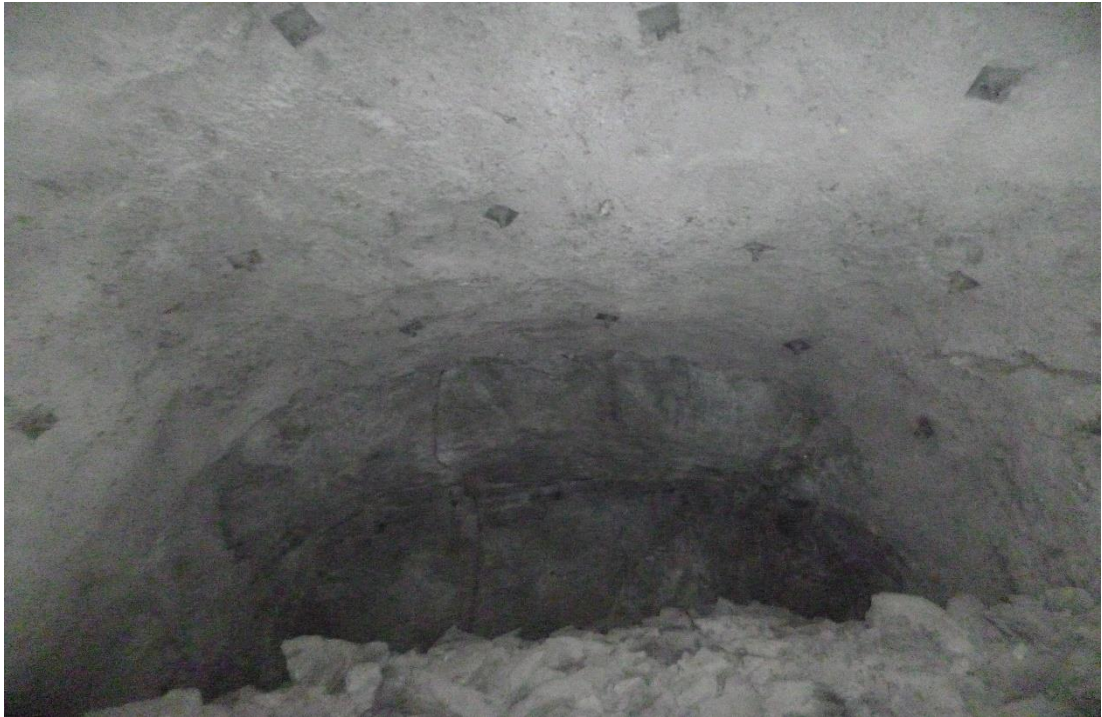
Figura 54: Sostenimiento con pernos python
