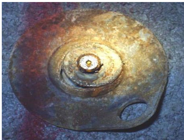
Figura 41: Placa de Reparto del hydrabolt y el indicador de carga punto amarillo.
