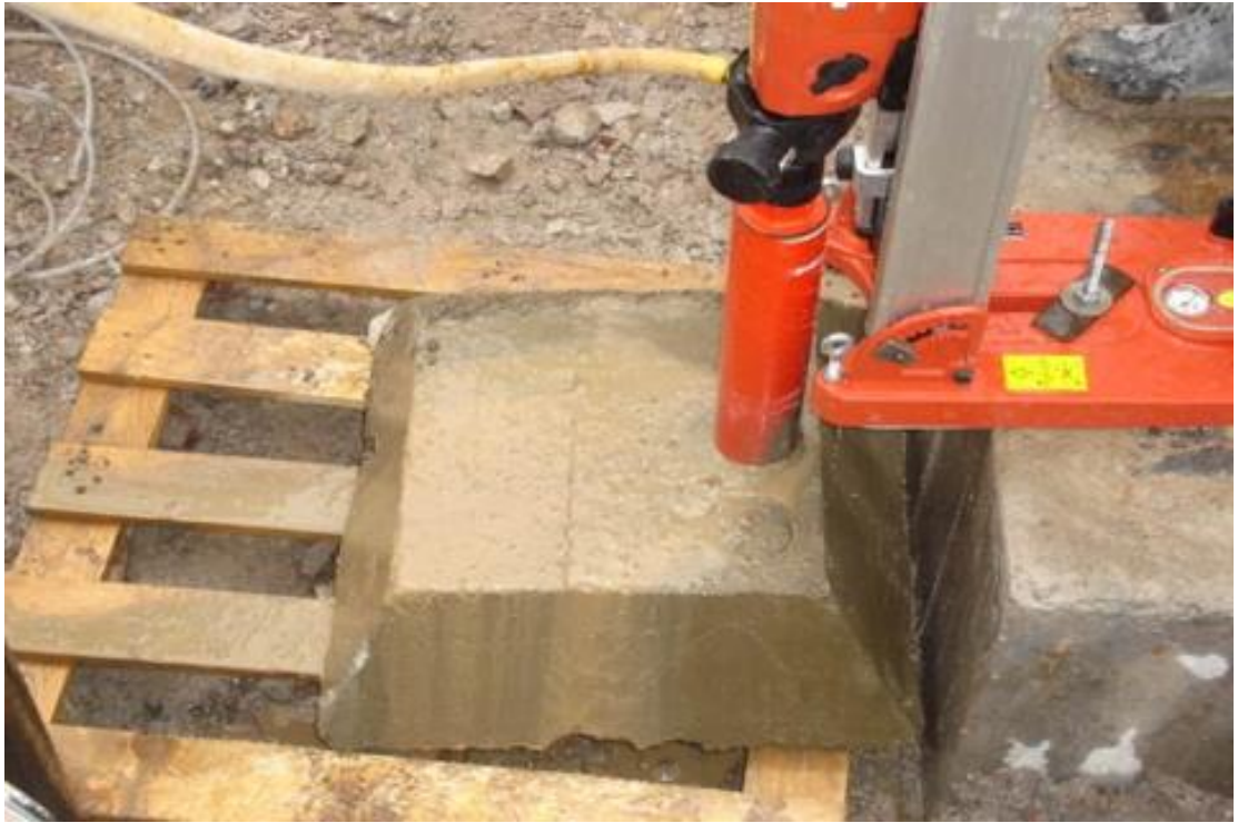
Figura 37: Batea de Shotcrete, para obtención de testigos para ensayos de compresión.
