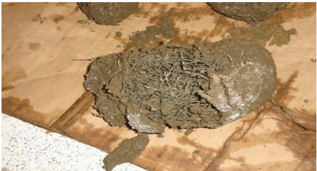
Figura 30: Mezcla de fibra metálica y hormigón
