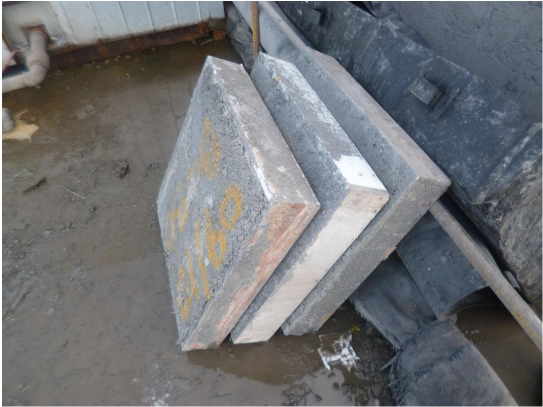
Figura 60: Panel de muestreo para verificar la resistencia del shotcrete
