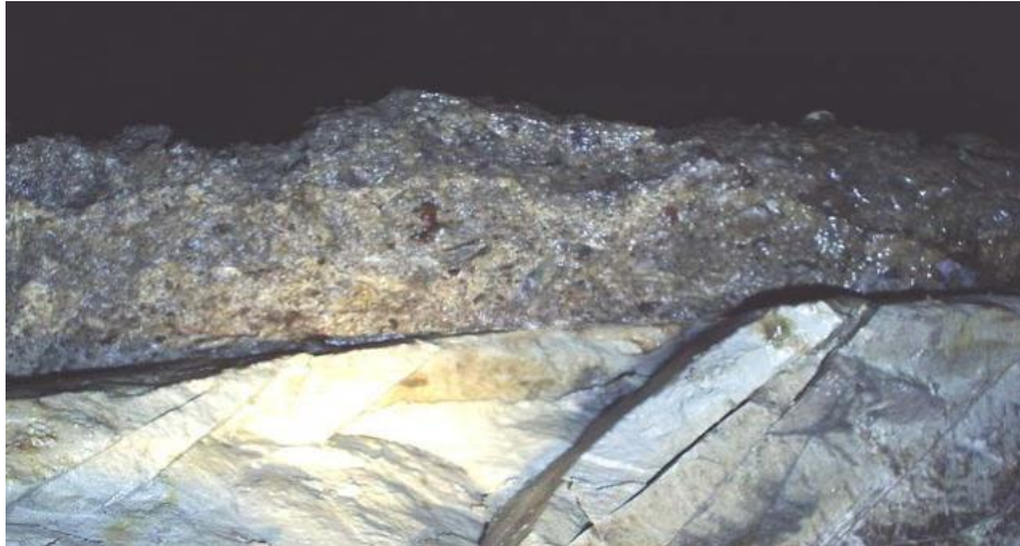
Figura 21: Aspecto y color del Shotcrete.
