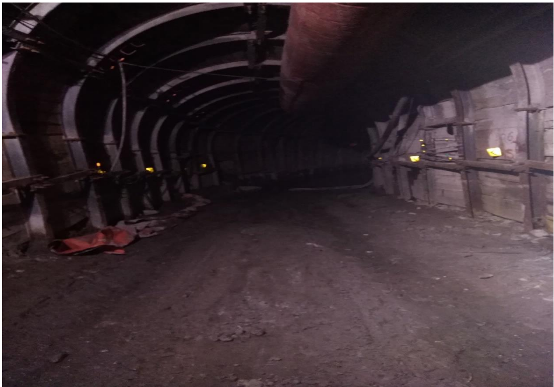
Figura 57: Sostenimiento con cimbras tipo H
