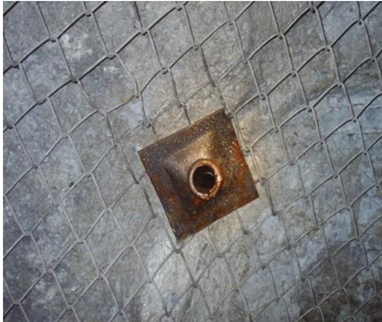
Figura 44: Malla de Eslabones o trenzada fijada a la roca con Split Set.
