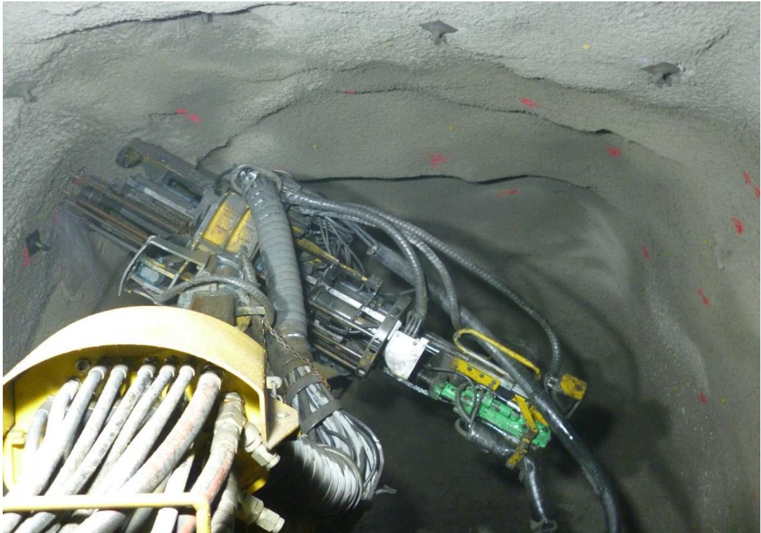
Figura 56: Sostenimiento de shotcrete con pernos python
