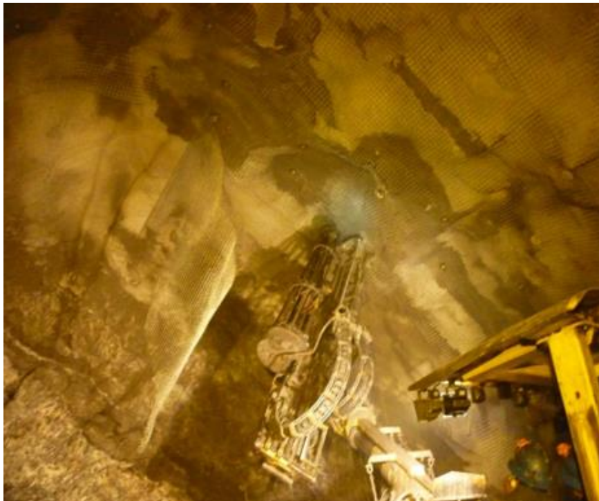
Figura 45: Instalación mecanizada de Malla Electro-soldada.
