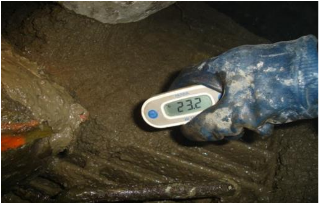
Figura 36: Medición de Temperatura de la mezcla para Shotcrete.
