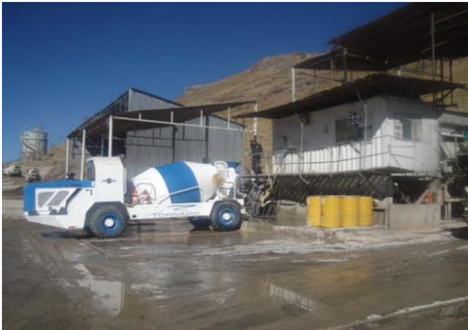
Figura 35: Mezcla vía húmeda abastecido al Tornado para ser Transportado.
