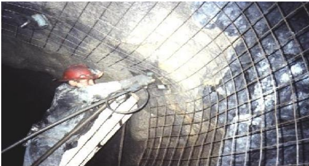
Figura 46: Instalación manual de Malla Electro-soldada.
