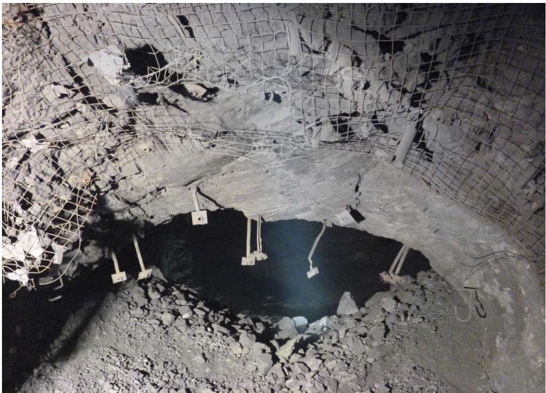
Figura 55: Sostenimiento con malla más pernos Split set
