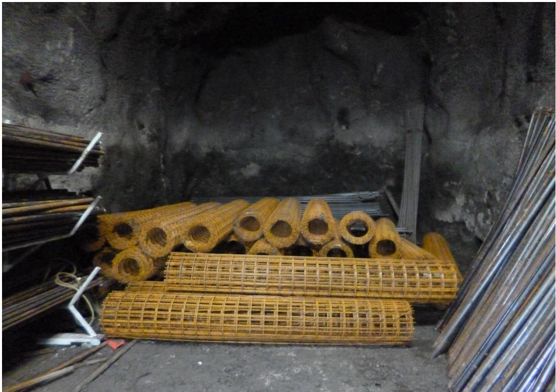
Figura 59: Materiales de sostenimiento (malla electrosoldada)
