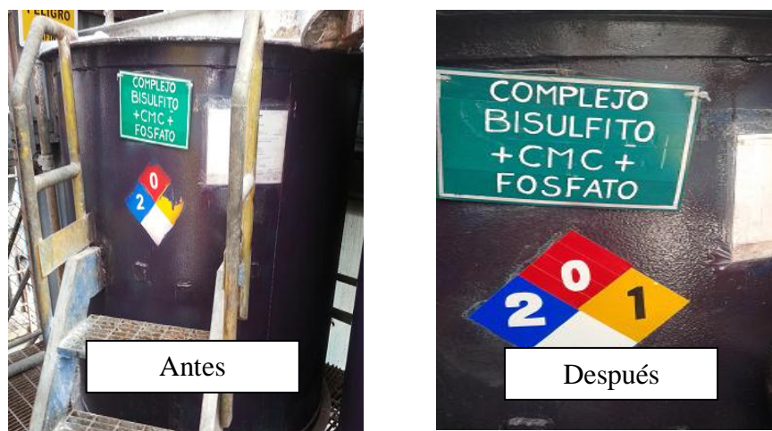
Figura N° 3.14: Tanque de complejo
