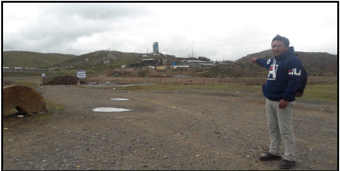
IMAGEN N° 03: INSTALACIONES DE PROCESAMIENTO DE MINERAL
