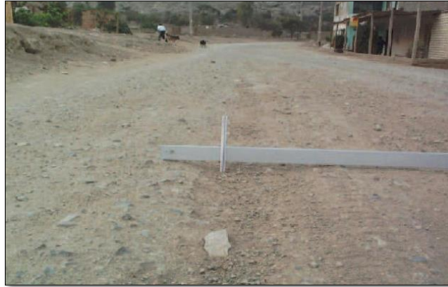
Imagen 2. Huellas / hundimientos sensibles al usuario pero < 5 cm Fuente: MTC
