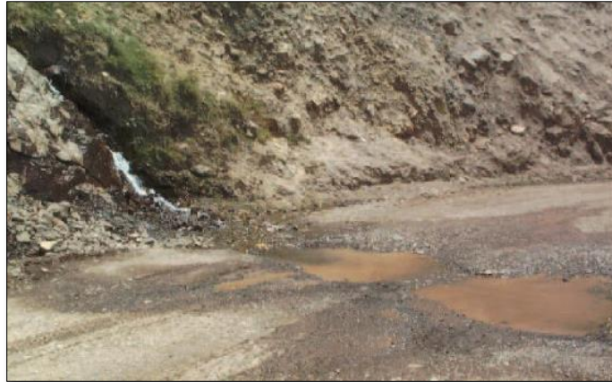
Imagen 13. CRUCE DE AGUA Fuente: MTC
