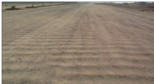
Imagen 11. Gravedad 1: Sensible al usuario, pero < 5 cm Fuente: MTC
