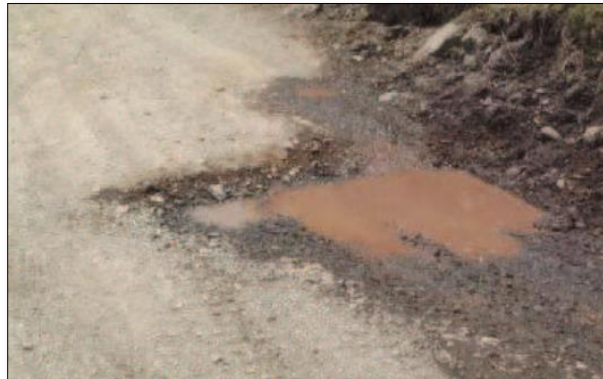
Imagen 8. Gravedad 1: Pueden repararse por mantenimiento rutinario Fuente: MTC
