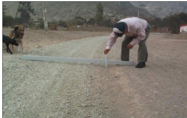
Imagen 3. Huellas/hundimientos entre 5 cm y 10 cm Fuente: MTC
