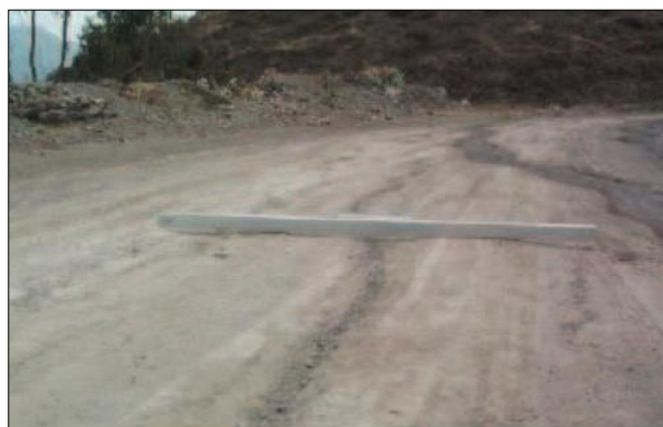
Imagen 5. Gravedad 1: Sensible al usuario pero < 5 cm Fuente: MTC
